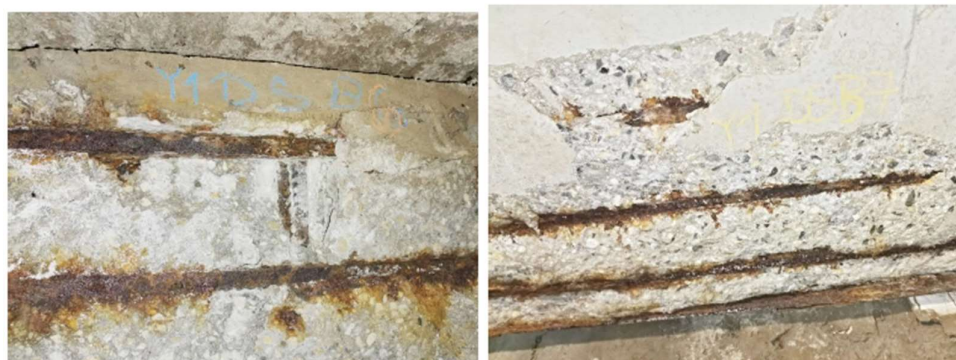
Obrázek 25 – Betonářská výztuž na horní desce prvního segmentu
