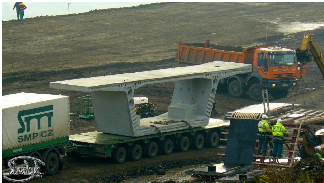
Obrázek 6 – segment použitý pro most u Prackovic (2. generace)
