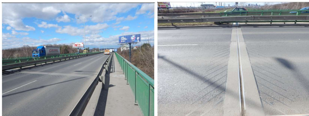
Obrázek 22 – šířkové uspořádání ve směru staničení (vlevo), mostní závěr nad O1 (vpravo)
