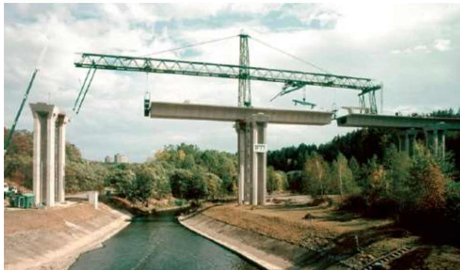
Obrázek 13 – Montáž mostu metodou letmé montáže
