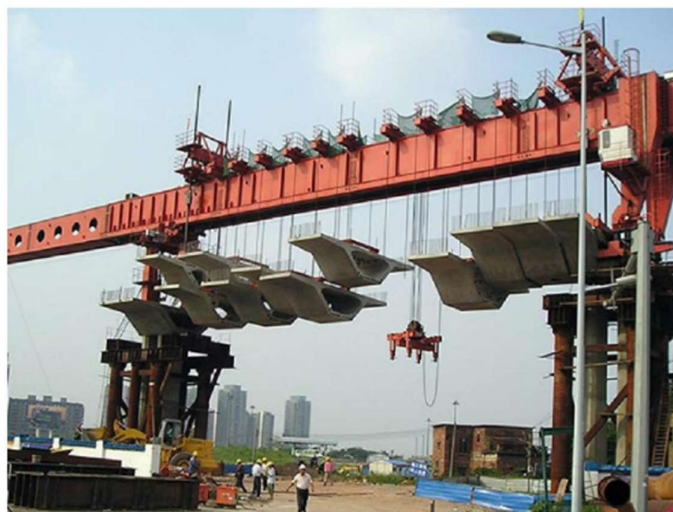
Obrázek 11 – Montáž na skruži
