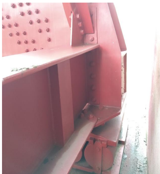
Obrázek 11 - Dolní příčník nad podporou
