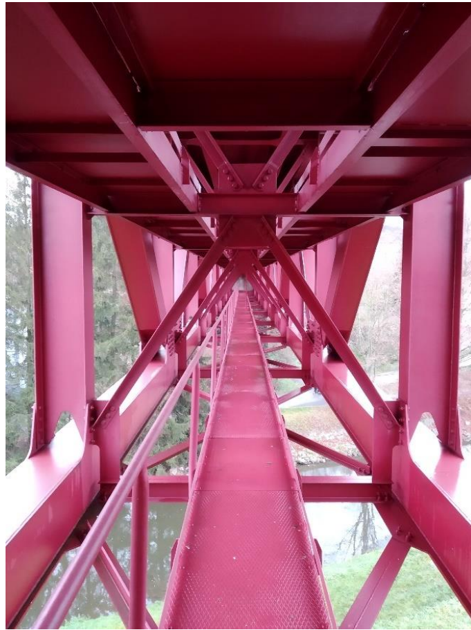
Obrázek 13: Příčné ztužení
