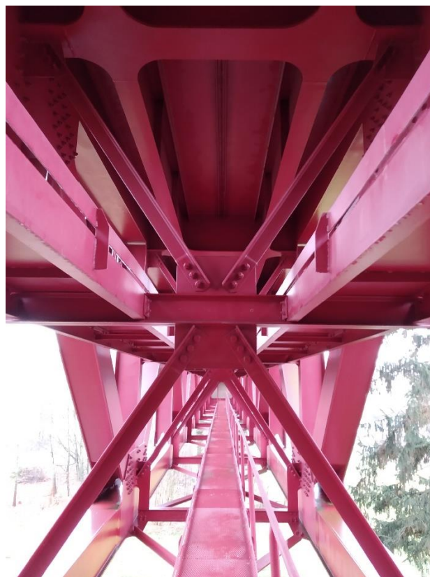
Obrázek 4: Příčné uspořádání mostu
