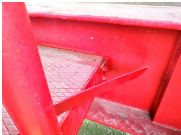
Obrázek 26: Deformovaný okopový plech na revizní látce
