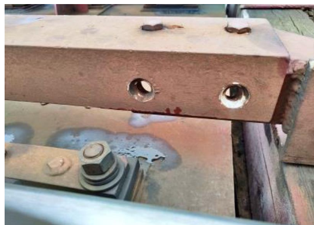
Obrázek 27: Chybějící šrouby na přídržnici
