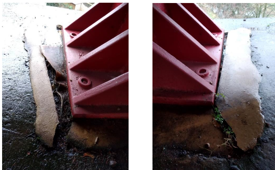
Obrázek 22: Pevné ložisko
