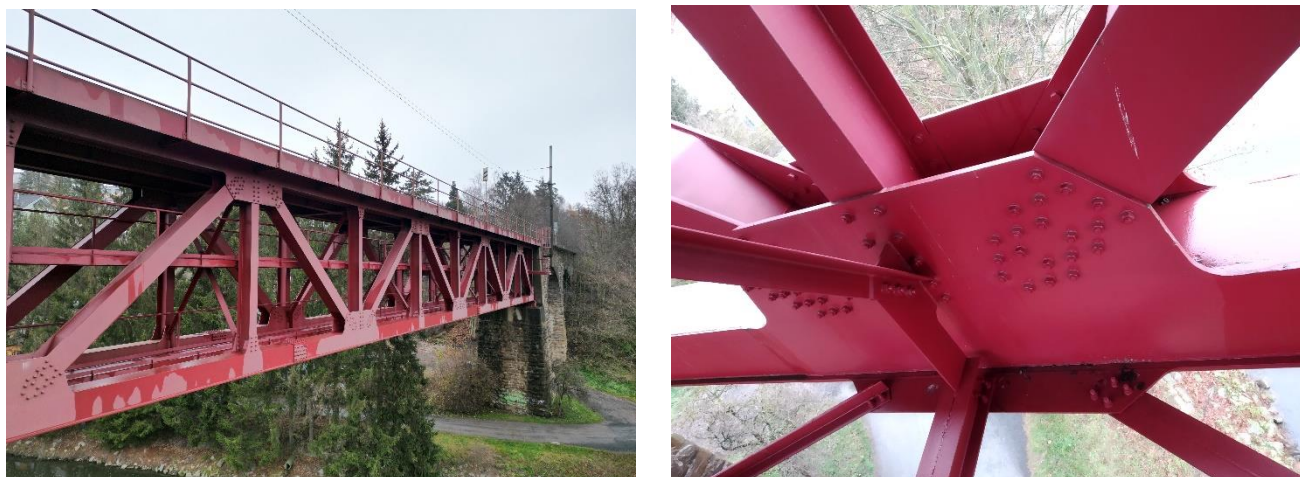
Obrázek 18: Hlavní nosník – pohled a styčnik
