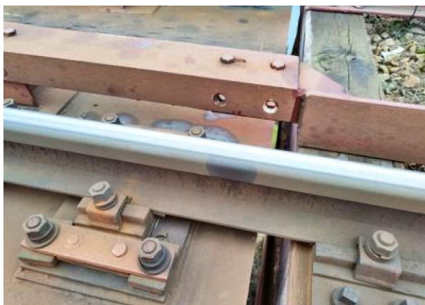
Obrázek 27: Chybějící šrouby na přídržnici
