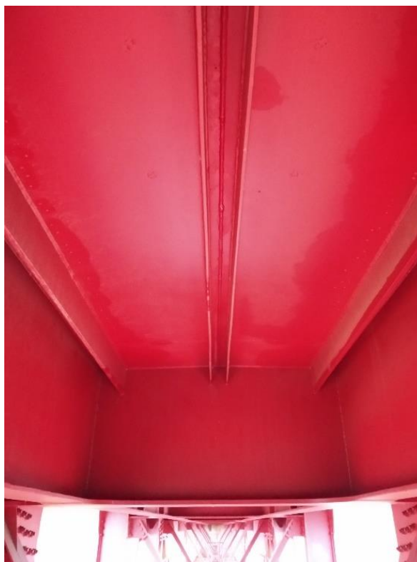
Obrázek 9: Mostovka - podélné výztuhy
