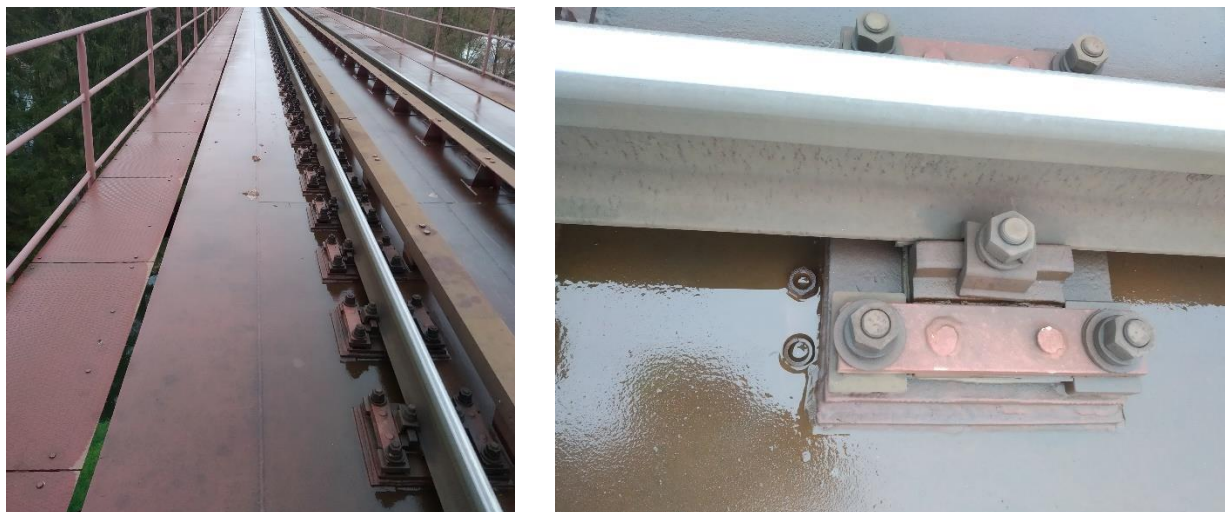
Obrázek 16: Přímé upevnění kolejnic
