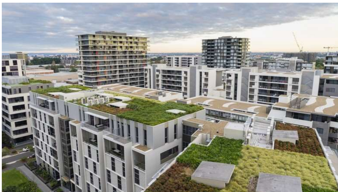
Obrázek 4 Využití střech s retenční vrstvou v zástavbě [27]
