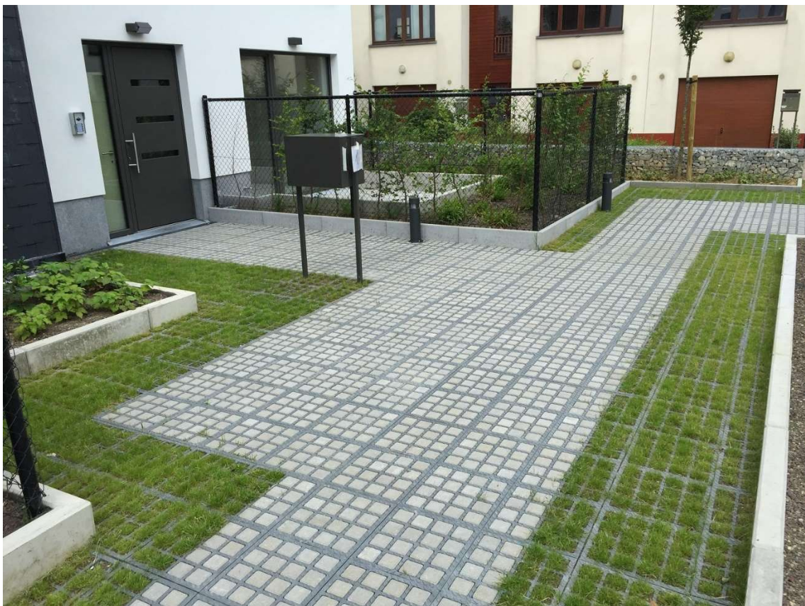
Obrázek 5 řešení propustnosti zpevněného povrchu zasakovacími rošty [28]
