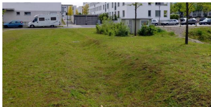
Obr. č. 13 Vsakovací průleh
