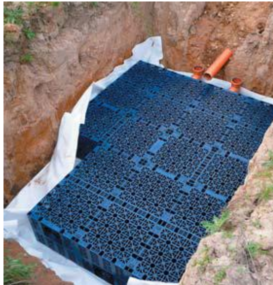
Obr. č. 17 Vsakovací galerie ze vsakovacích boxů
