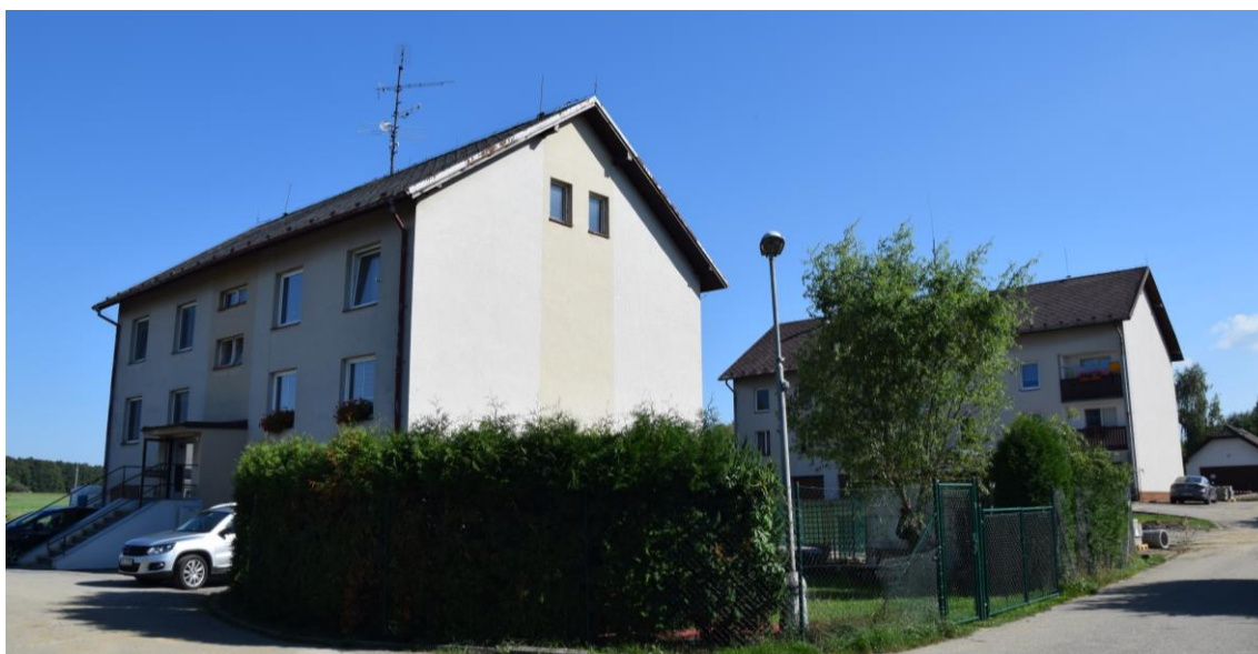
Obr. 15: Zástavba bytových domů v Dolním Třeboníně
