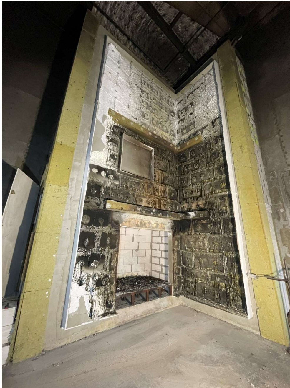
Obr. 44 – Pohled na zkoušku s bariérou po odstranění fasádní omítky
