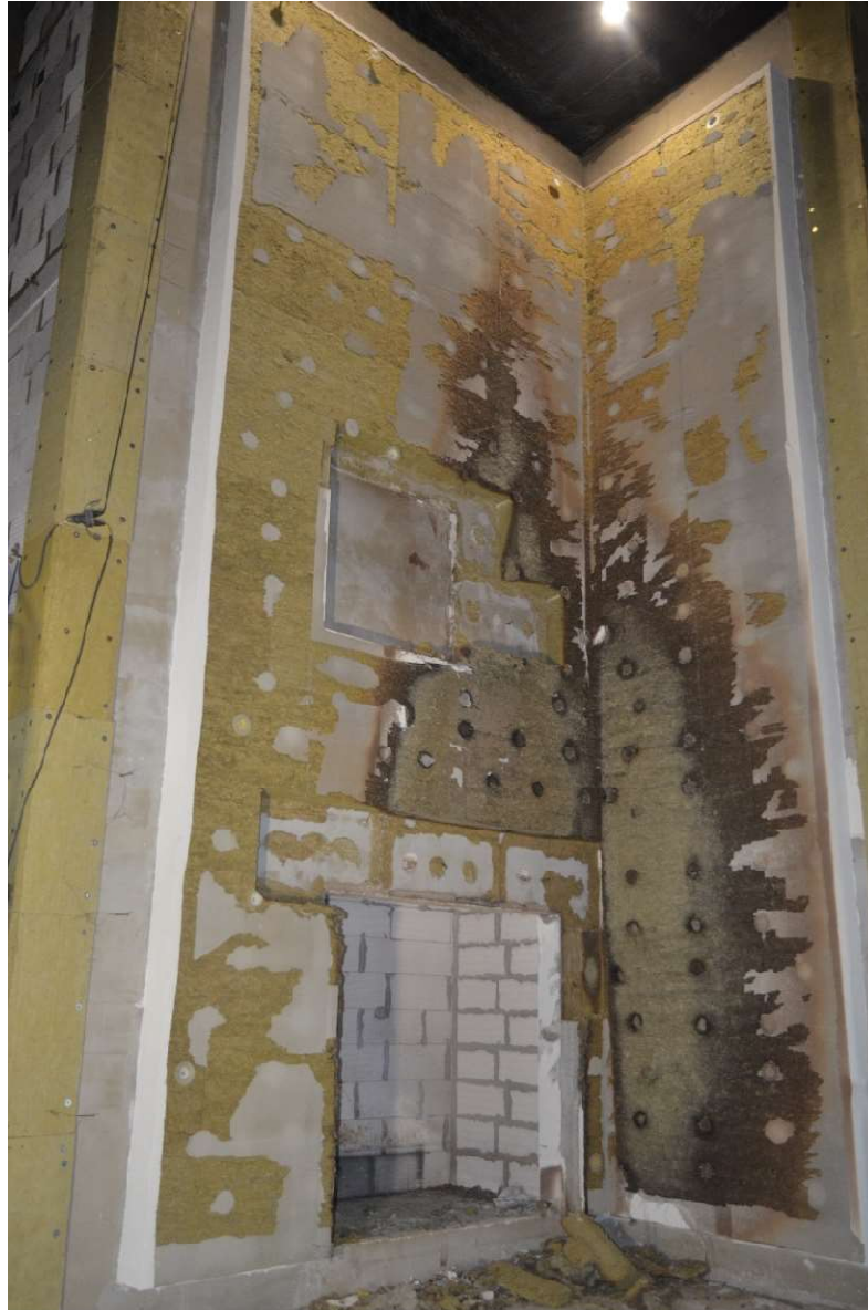
Obr. 41 – Pohled na zkoušku MW po odstranění fasádní omítky
