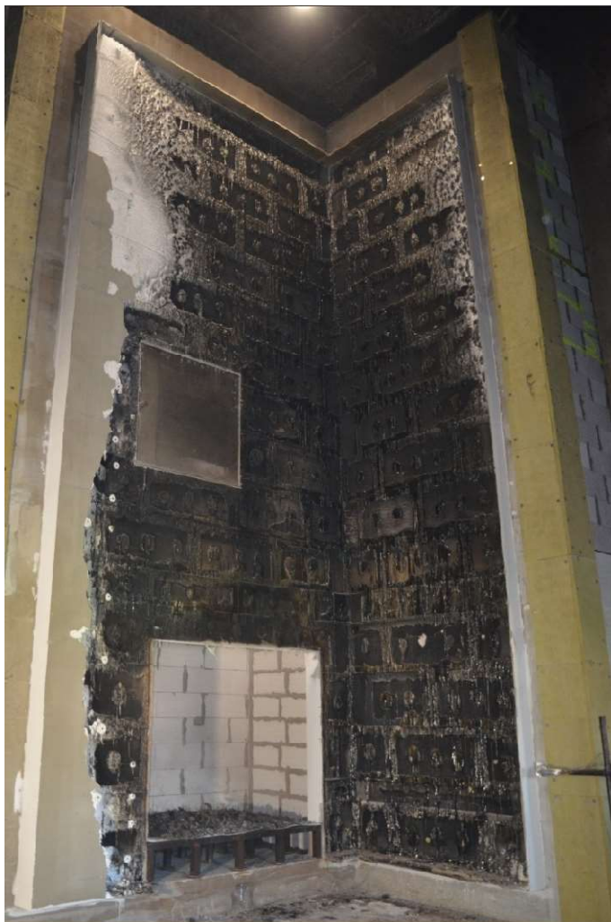
Obr. 39 – Pohled na zkoušku EPS po odstranění fasádní omítky
