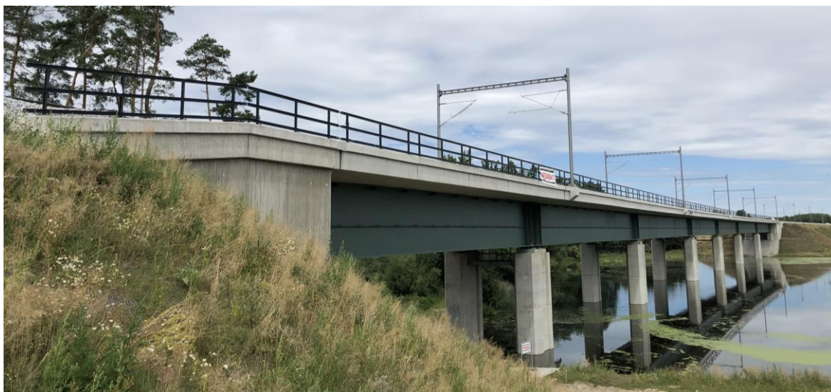
Obr. 12 Fotka mostu přes Kamenný rybník, červenec 2022
