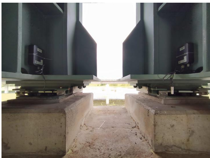
Obr. 29 Umístění potenciometrického snímače dráhy (SS:NK) a měřících ústředen typu StatoTest na pilíři P4 a NK2 a NK3.
