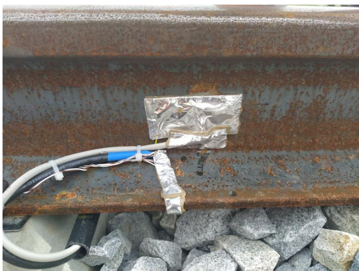
Obr. 20 Zakrytí snímačů na kolejnici
