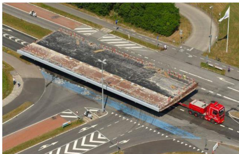
Obr. 21 - mostní pole mostu Skovbrynet S- Station (12)
