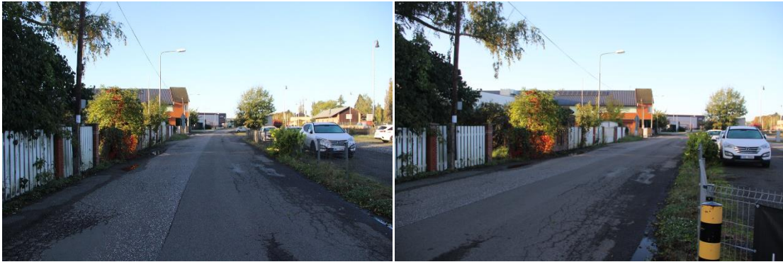
Obrázek 16 - Odvodňová část ul. Nerudova do kanalizace
