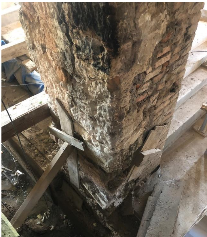
obr. 20 - Zděný pilíř P1
