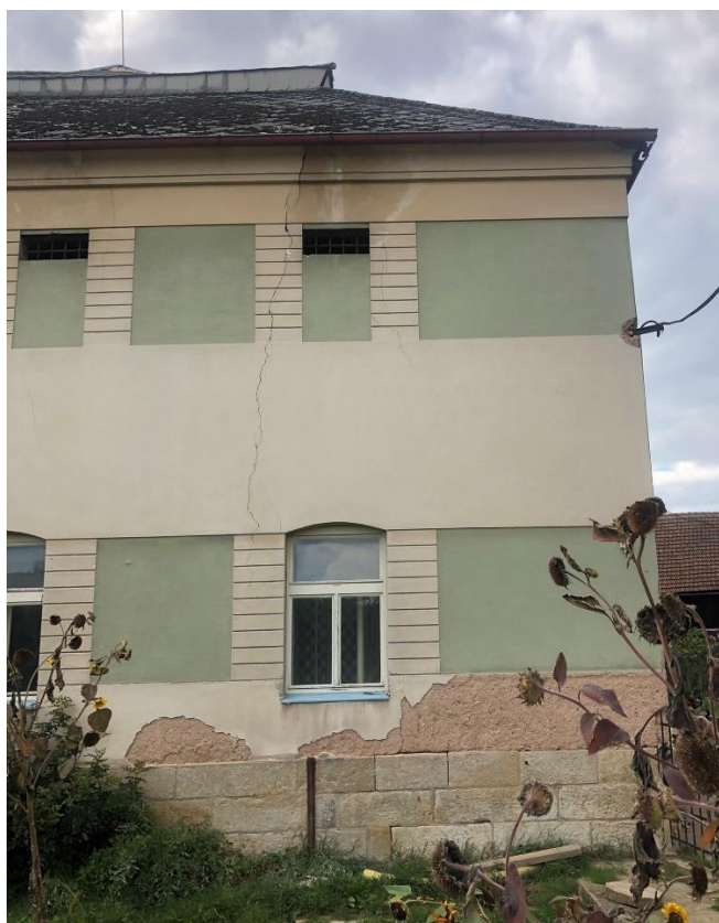
obr. 16 - Pohled na severovýchodní nároží
