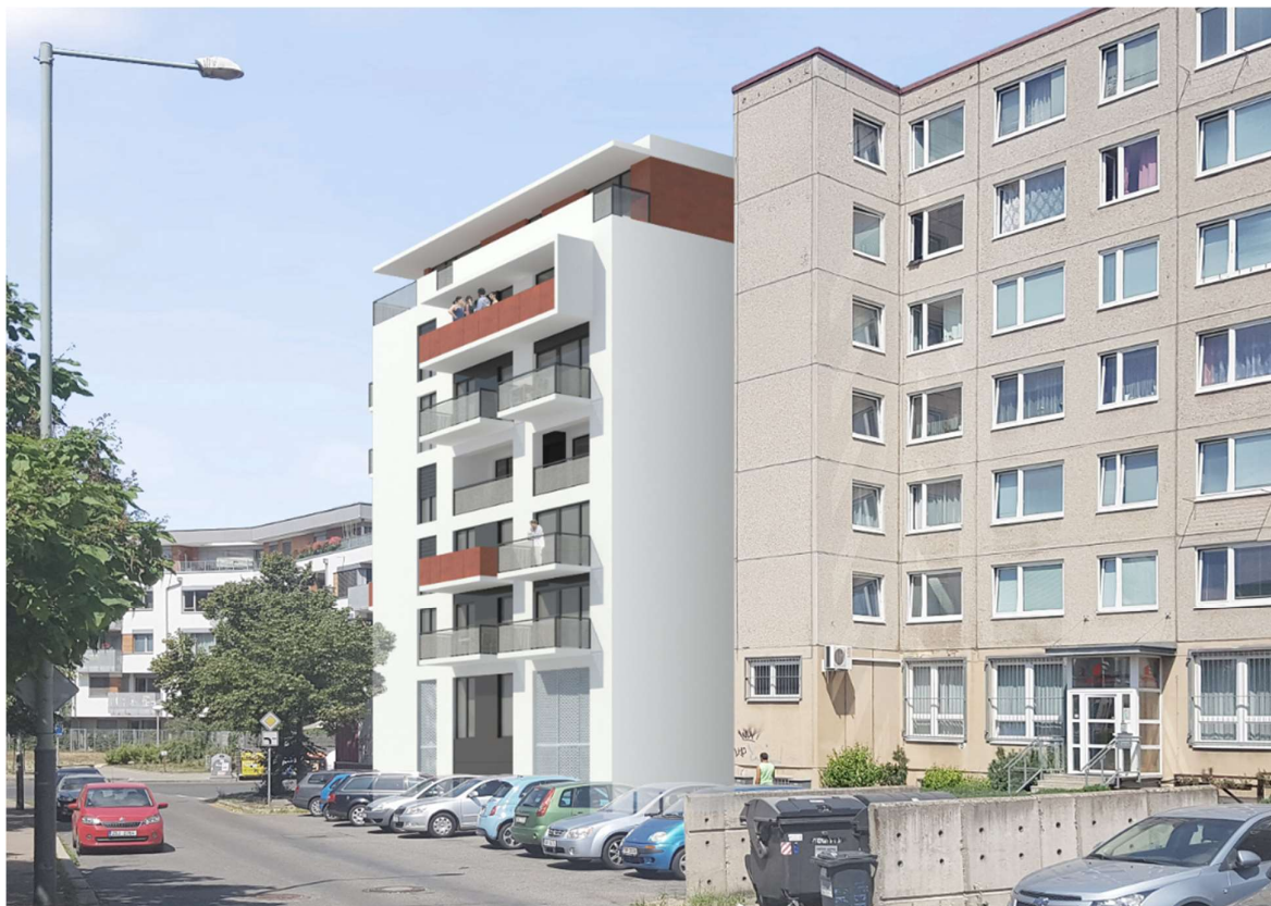
Obr. 3: Bytový dům Kardašovská [1]
