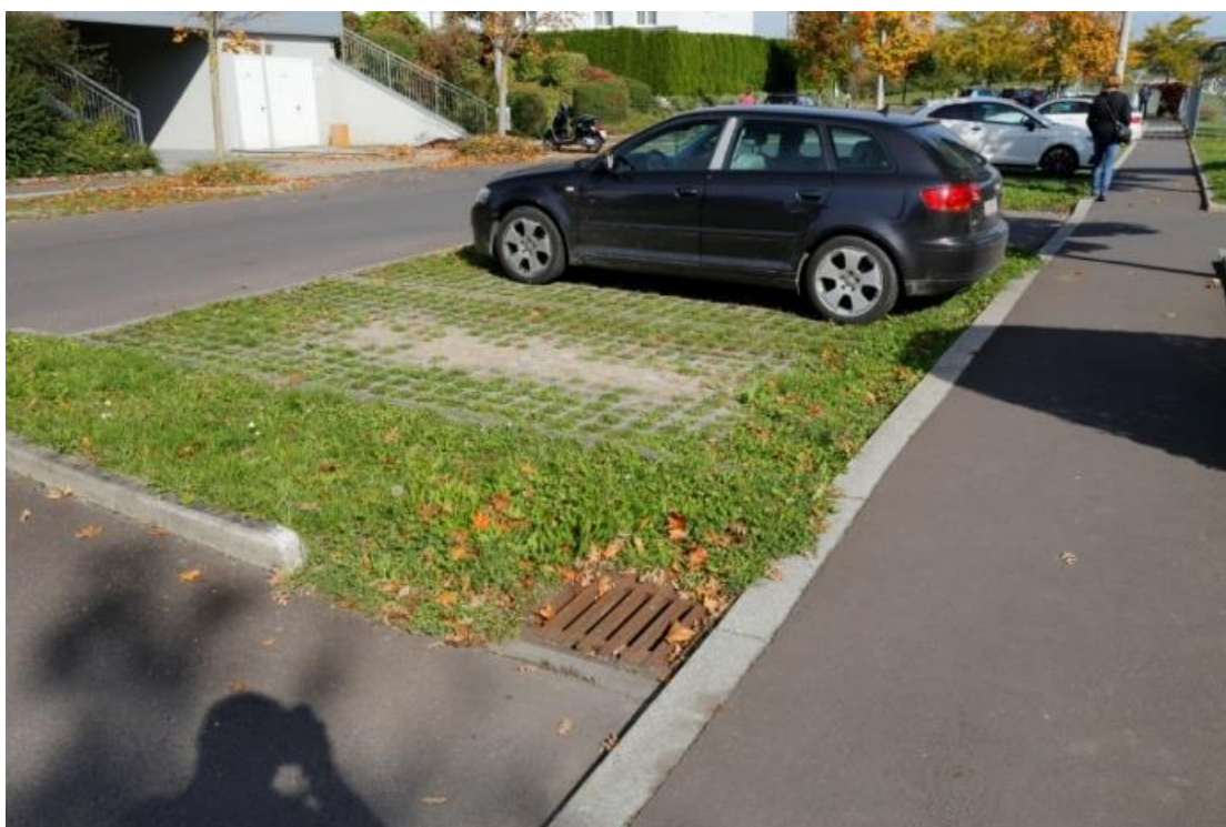
Obr. 7 - Zatravněná parkovací stání (Foto J. Vítek)
