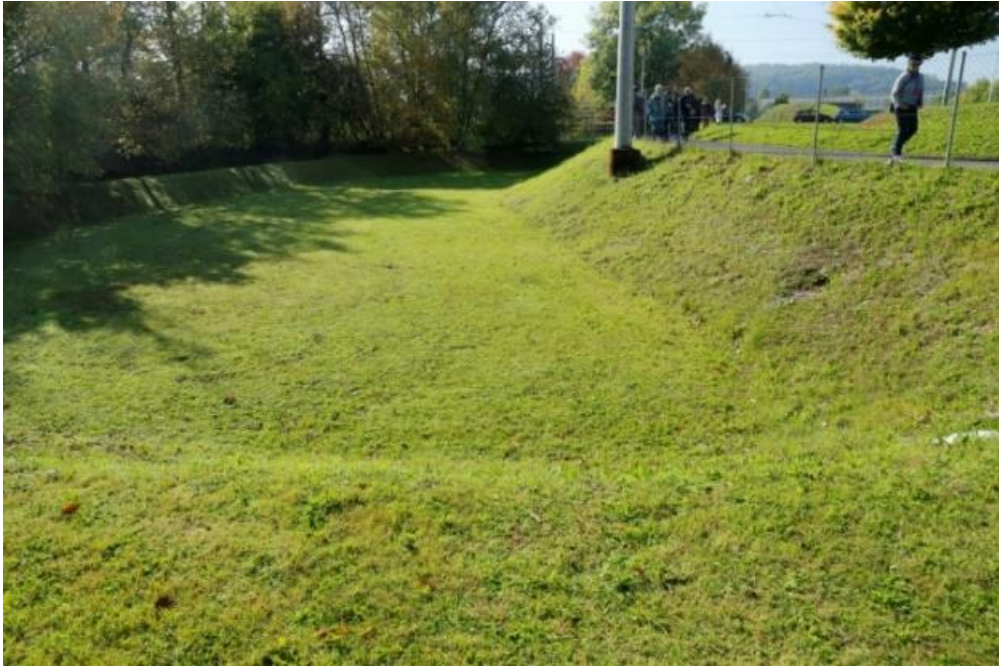
Obr. 8.1 - Vsakovací nádrž v SolarCity (Foto J. Vítek)
