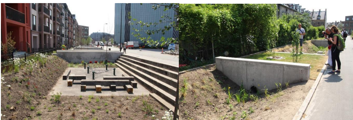
Obr. 9 - Kaskáda retenčních nádrží v Carlsberg City v Kodani (Foto L. Pančíková)
