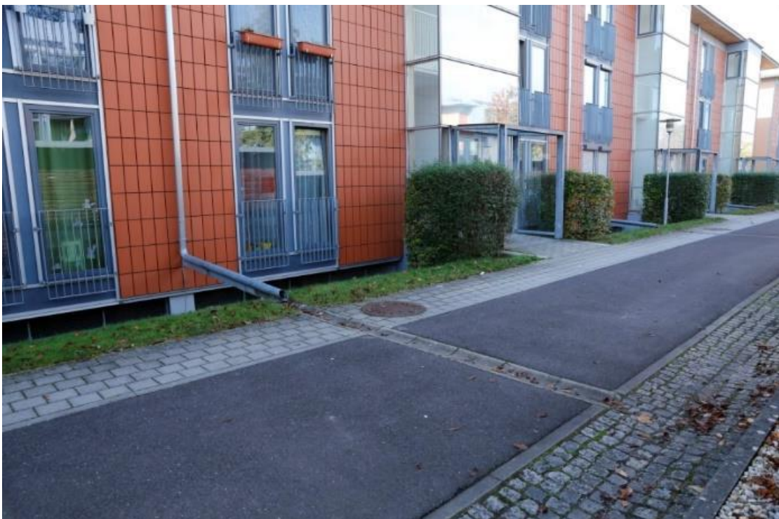
Obr. 8.2 - Kanálky pro odvod vody ze střech (Foto J. Vítek)
