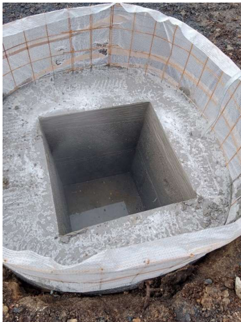
Obr. 6.1.8 Odbedněný kalich pro osazování sloupů
