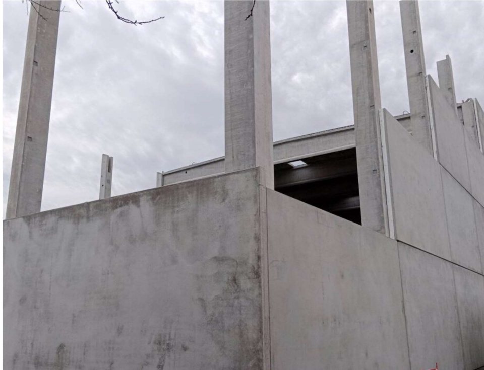
Obr. 6.2. 4 Montáž sendvičových panelů
