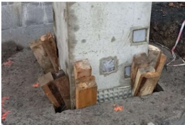
Obr. 6.2. 2 Klínování sloupu do svislé polohy
