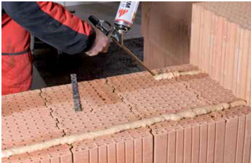
Obr. 6.3.2: Nanášení zdící pěny
