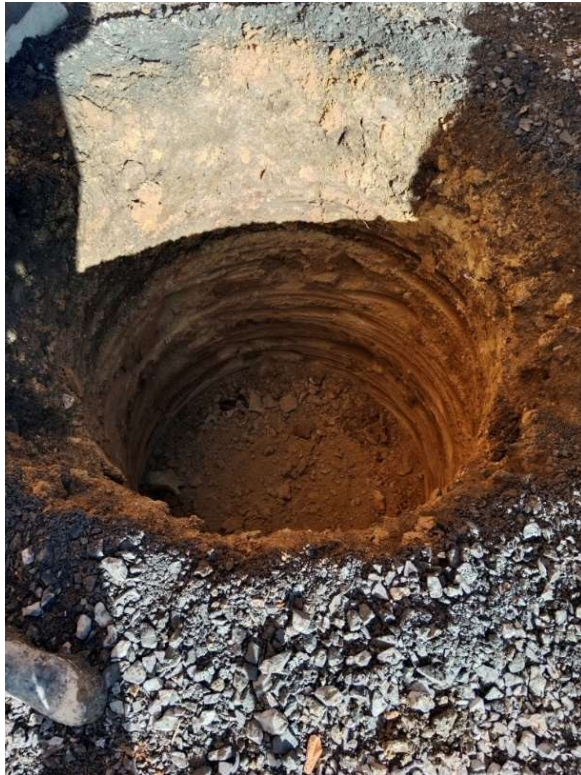
Obr. 6.1.4 Vrt kalichu piloty
