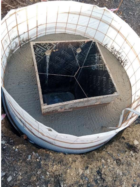
Obr. 6.1.7 Dokončená betonáž kalichu
