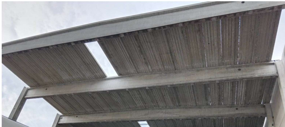
Obr. 6.2. 3 Osazování stropních panelů
