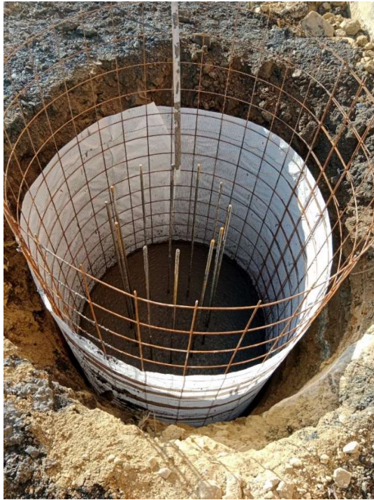
Obr. 6.1.6 Vybetonovaná pilota s bedněním a armaturou kalichu
