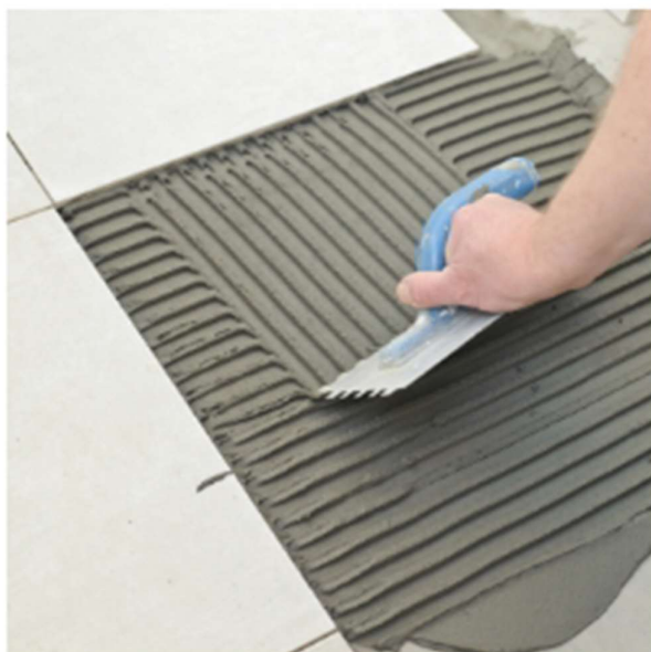
Obr. 6.5.3: Nanášení lepidla metodou floating
