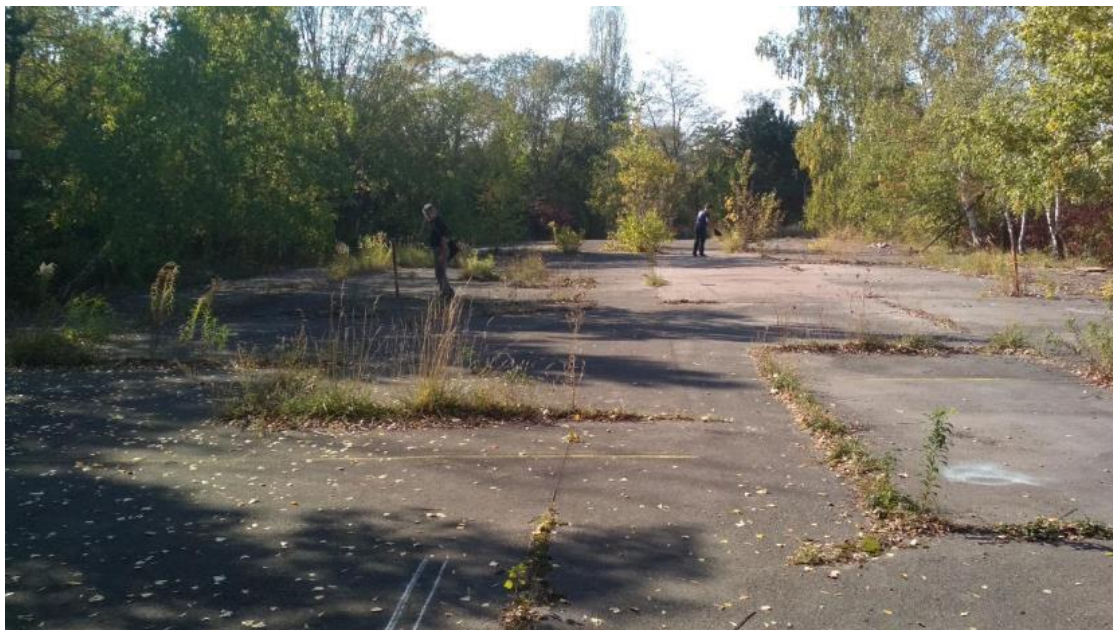
Obr. 12 Současný stav zájmového území, pohled z východu
