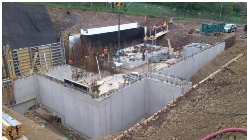
Obr. 47 Příklad hydroizolace spodní stavby bílou vanou [16]
