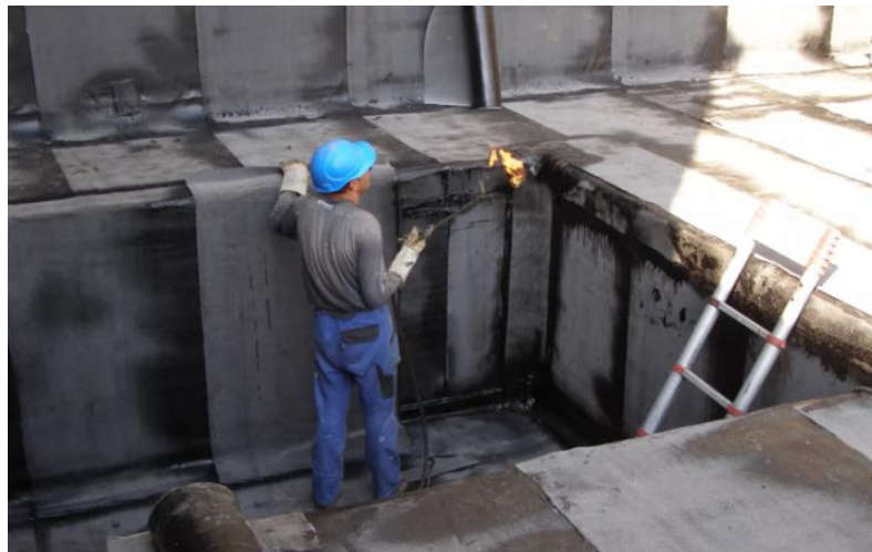
Obr. 46 Příklad hydroizolace spodní stavby černou vanou [15]
