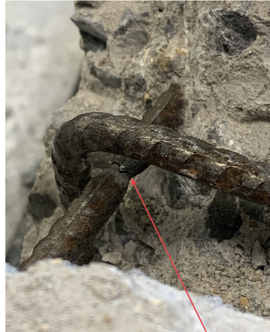
Obr. 2.55: Přetržená výztuž
