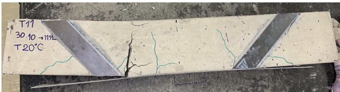
Obr. 2.84: Trámek zesílený na ohyb a smyk po porušení
