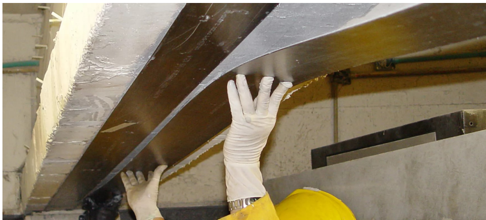
Obr. 1.6: Proces lepení lamely [30]
