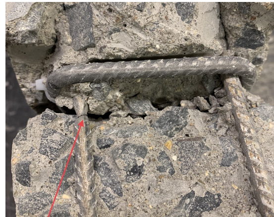
Obr. 2.83: Přetržení výztuže – čtyřbodový ohyb
