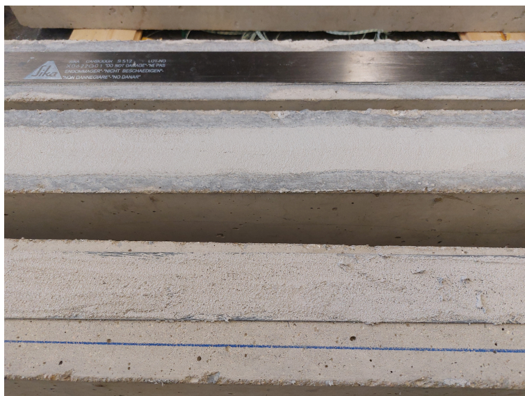
Obr. 2.43: Nanesené lepidlo na trámku a lamele
