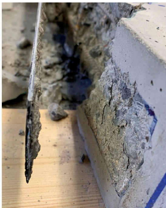
Obr. 2.62: Odchlípnutí lamely s krycí vrstvou betonu
