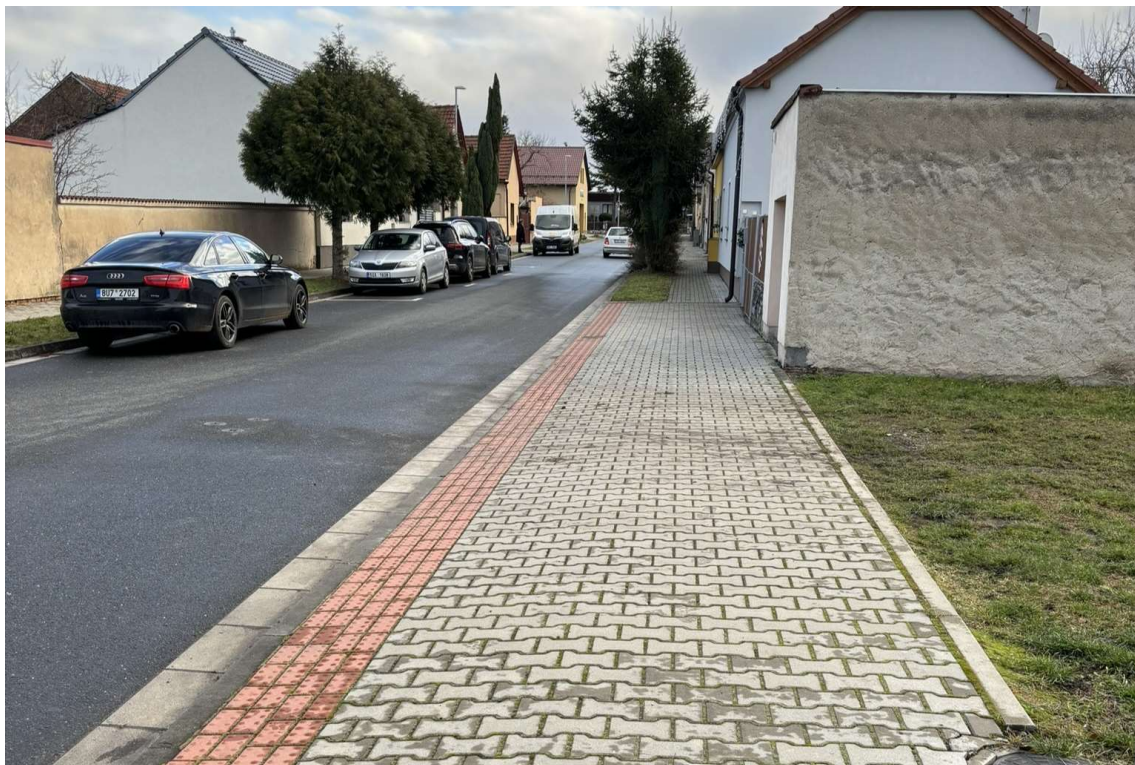
Obr. 5 – Současný chodník, přes který je navržen vjezd do zájmového území
