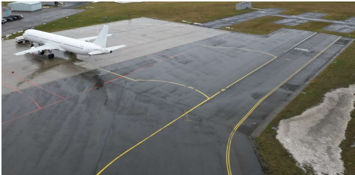
Obrázek 10 : Pohled na Pojezdový pruh APN M (zdroj: fotodokumentace lokality)
