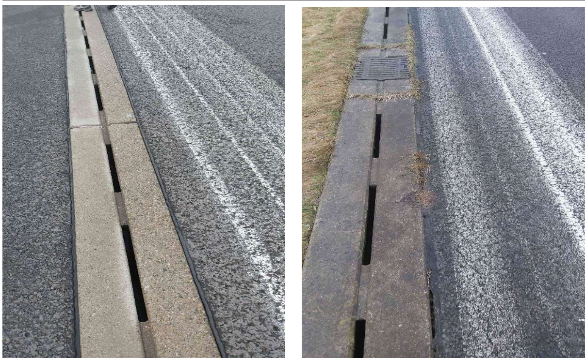
Obrázek 4: Pohled na štěrbinový žlab (zdroj: fotodokumentace lokality)
