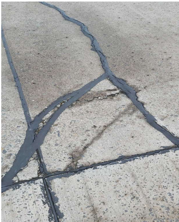
Obrázek 9 : Porušené a opravené CB desky (zdroj: fotodokumentace lokality)
