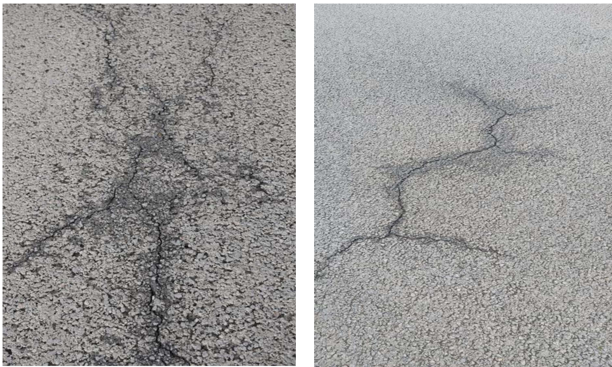
Obrázek 2: Příčné trhliny od poklesu původní CB vozovky (zdroj: fotodokumentace lokality)
