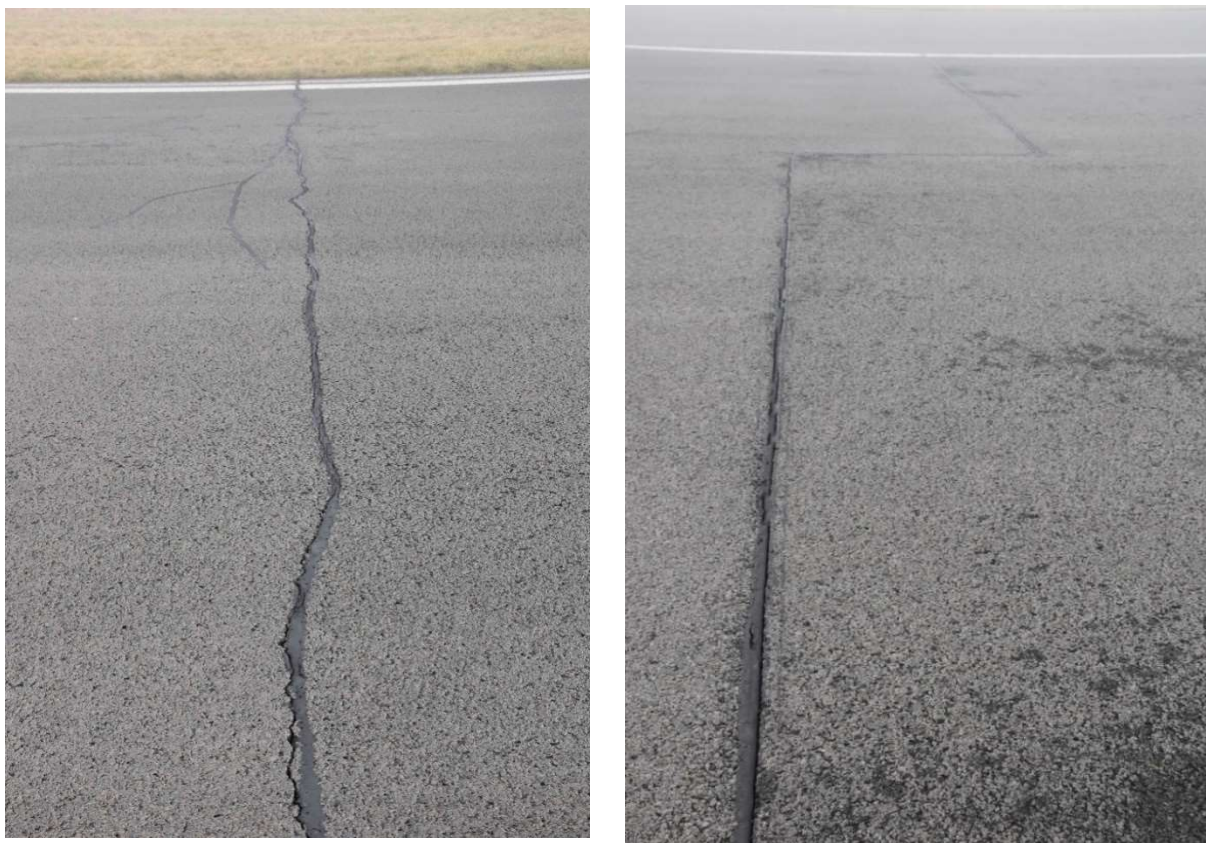
Obrázek 2: Příčné trhliny od poklesu původní CB vozovky (zdroj: fotodokumentace lokality)
