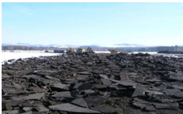
Obrázek číslo 3. [ Demolice stávající Plochy a dokončení rekonstrukce RWY ]
