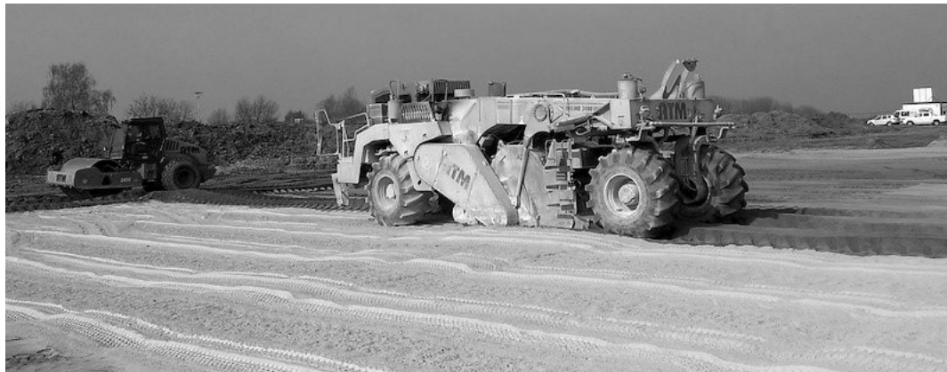
Obr. 6 Vápnenná stabilizace s použitím zemní frézy [11]
