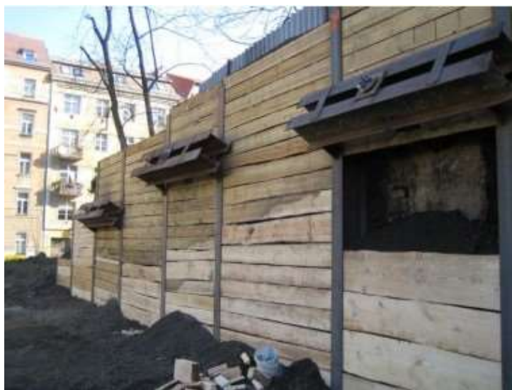
Obrázek 24 - Záporové pažení [9]
