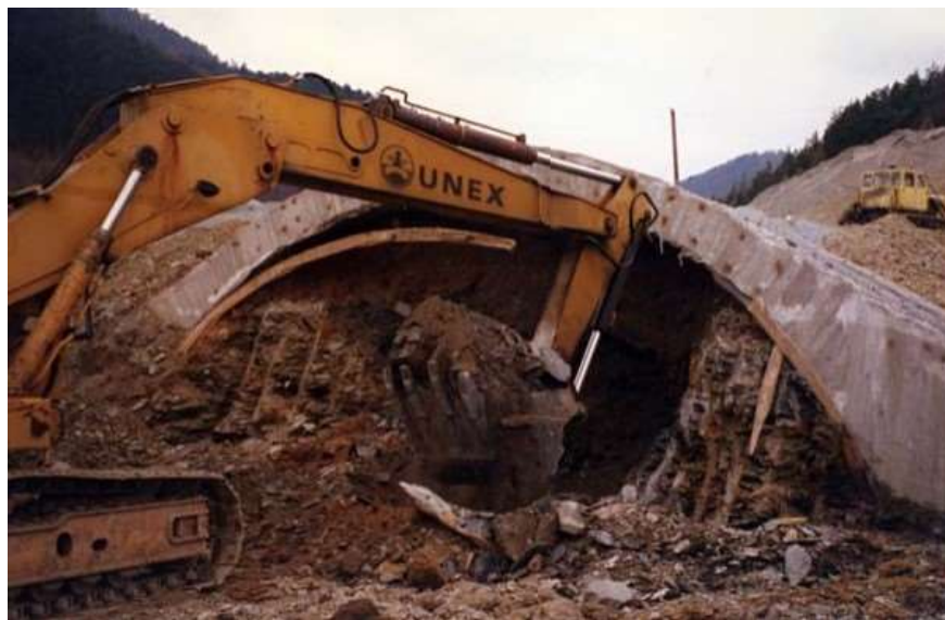
Obrázek 17 - Odtěžování kaloty pod klenbou [6]
