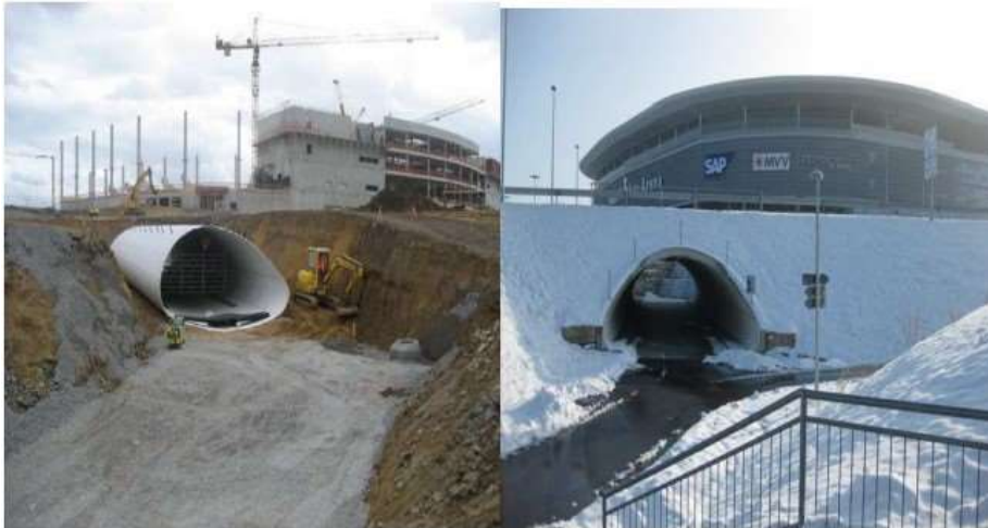
Obrázek 20 - Výstavba podchodu ze systému HAMCO [5]
