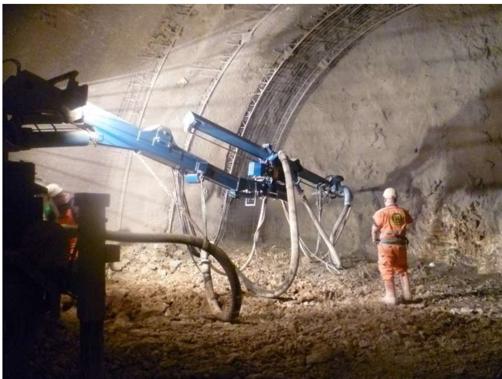
Obrázek 1 - Aplikace stříkaného betonu jako primární ostění [22]
