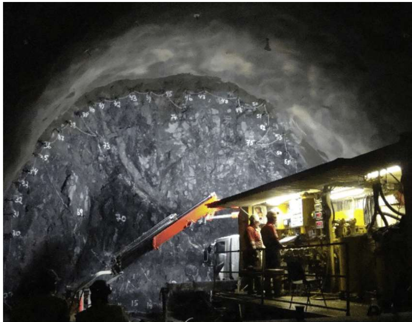
Obrázek 12 - Injektáž čelby [19]
