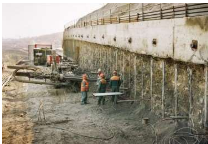
Obrázek 25 - Mikrozáporové pažení [9]
