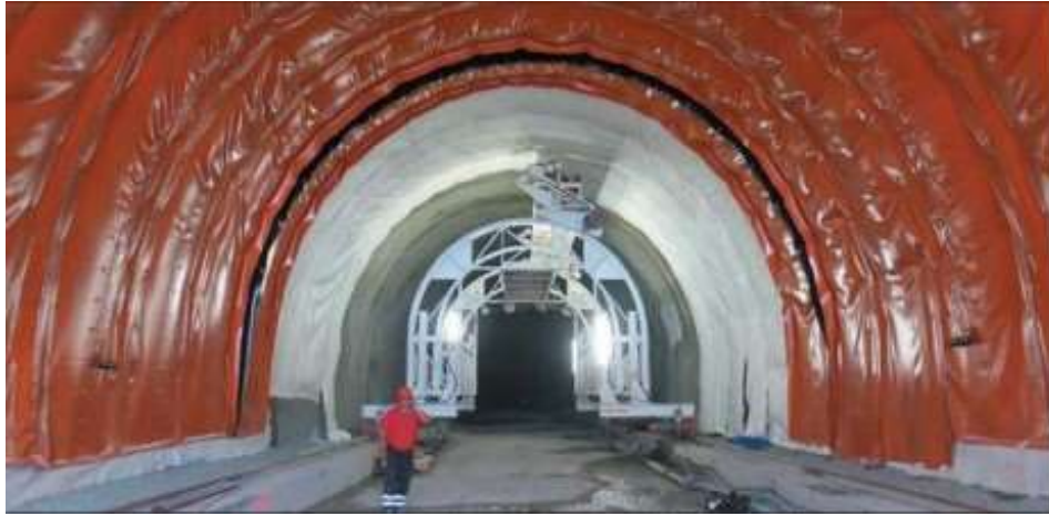
Obrázek 13 - Montážní plošina pro instalaci fóliové hydroizolace [3]
