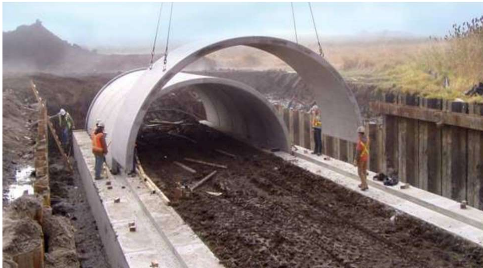
Obrázek 18 - Prefabrikovaná konstrukce systému BEBO [5]
