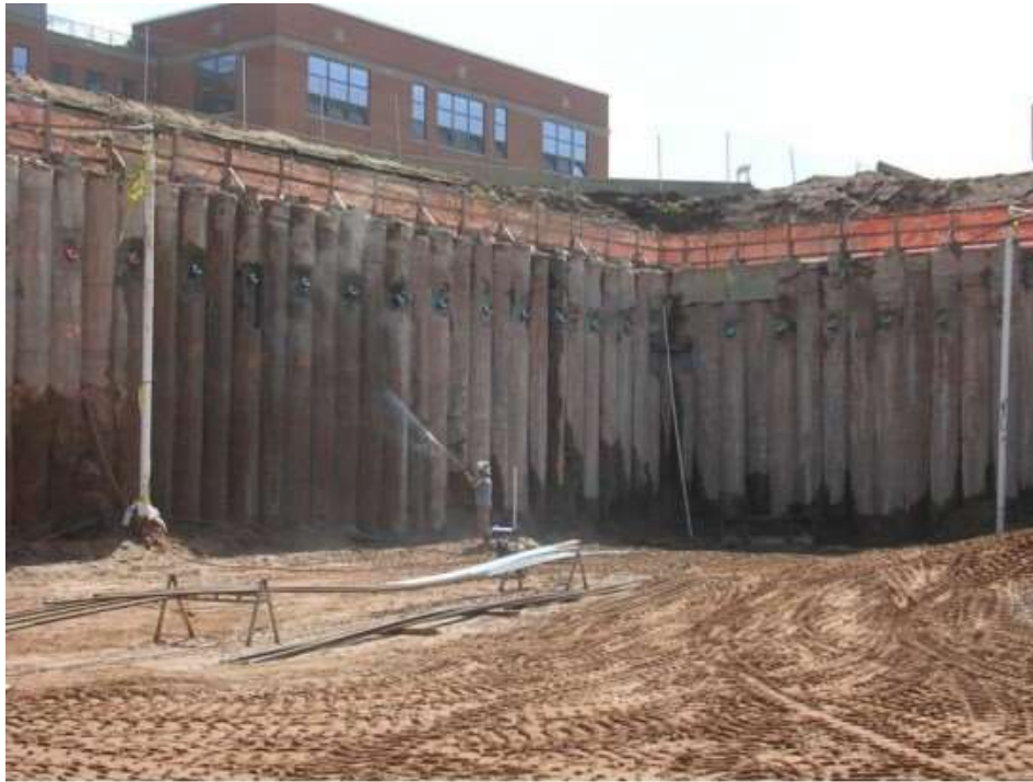
Obrázek 27 - Pilotová stěna [9]
