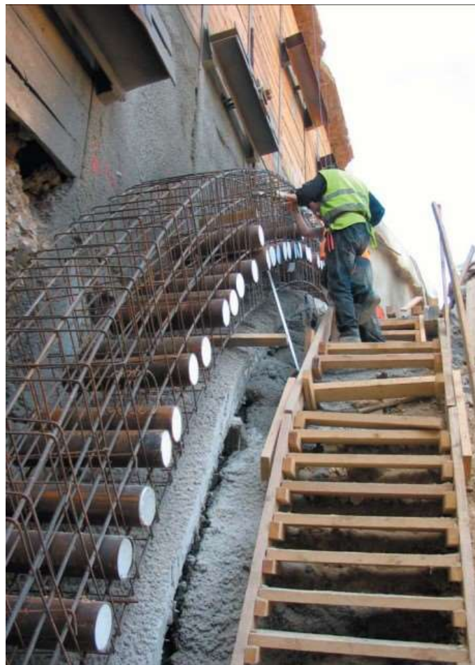
Obrázek 11 - Mikropilotové deštníky na portálu Cholupického tunelu [3]
