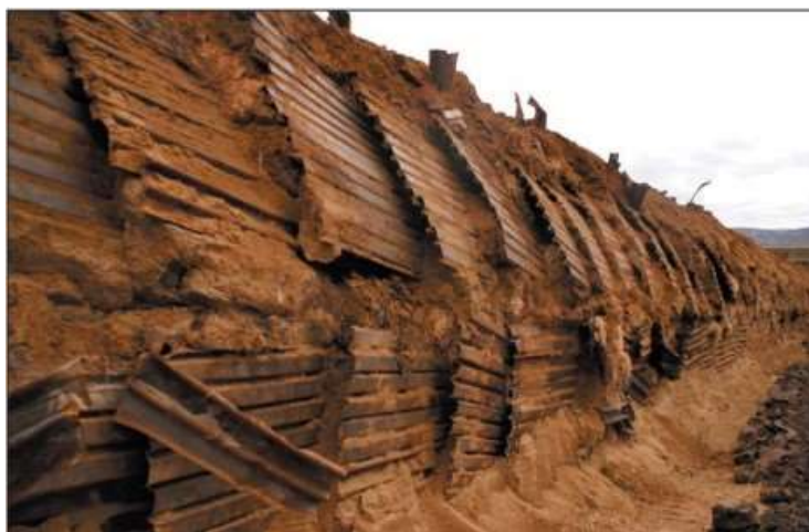
Obrázek 10 - Obnažené hnané pažení průzkumné štoly Cholupického tunelu [3]
