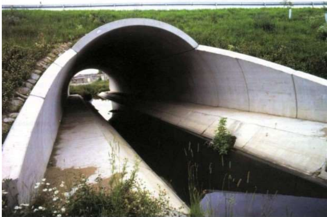
Obrázek 22 - Silniční most realizovaný prefabrikáty TOM 2 [5]
