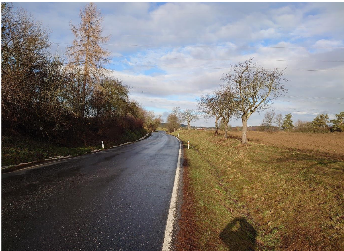
Fotografie č.2 – začátek úseku variant 3, 4 a 5 obchvatu, pohled po směru staničení
