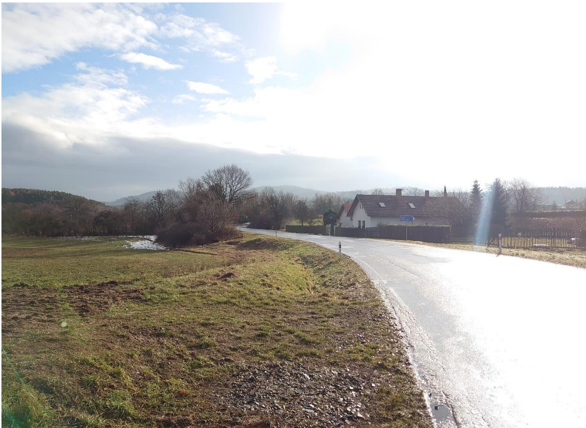
Fotografie č.3 – začátek úseku variant 3, 4 a 5 obchvatu, pohled proti směru staničení
