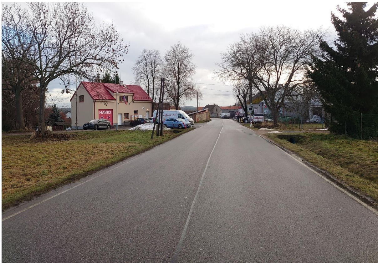
Fotografie č.34 – místo navrhovaného obratiště autobusů u obecního úřadu, pohled proti směru staničení
