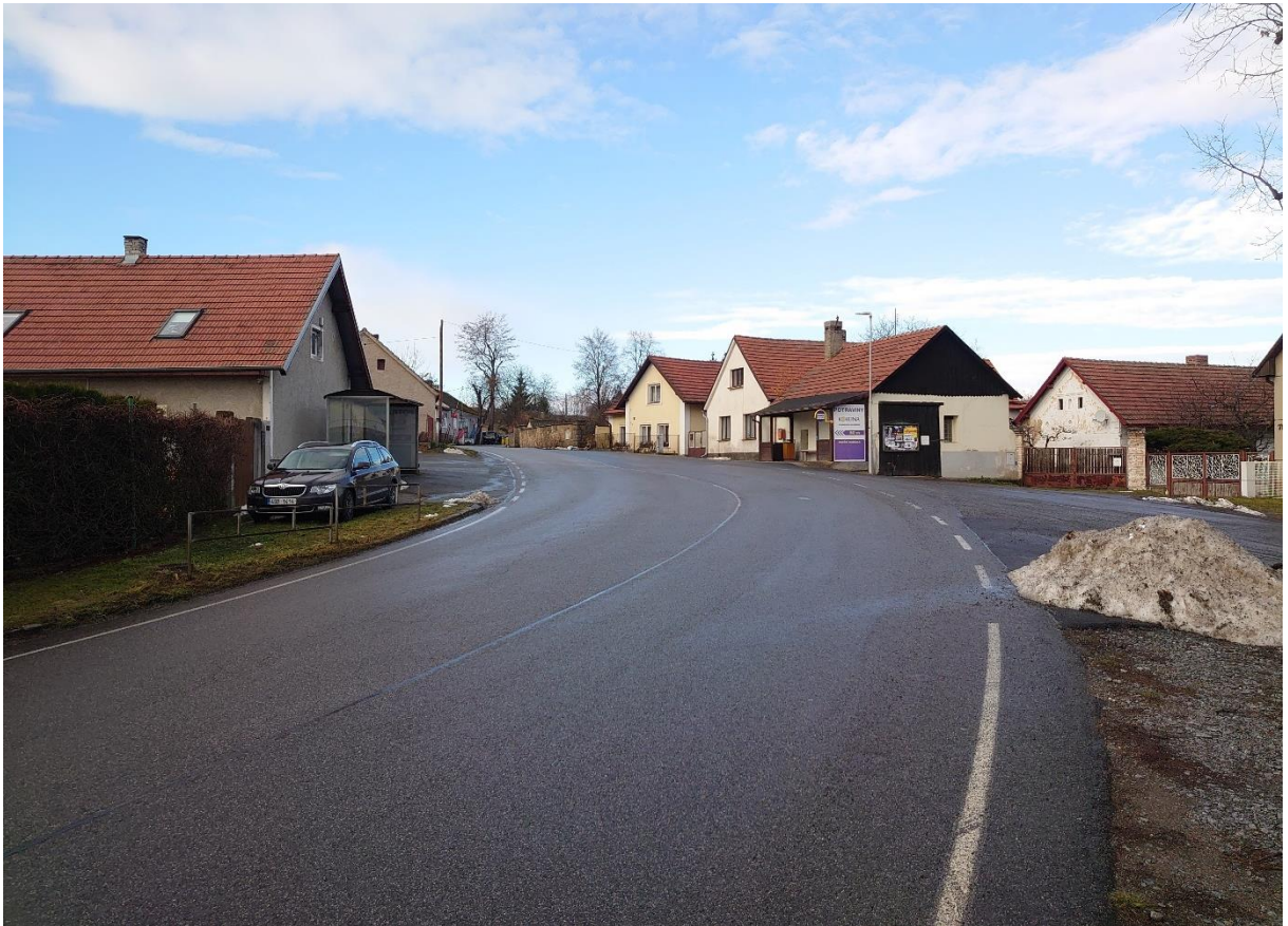
Fotografie č.25 – autobusové zastávky v obci Jablonná, pohled po směru staničení
