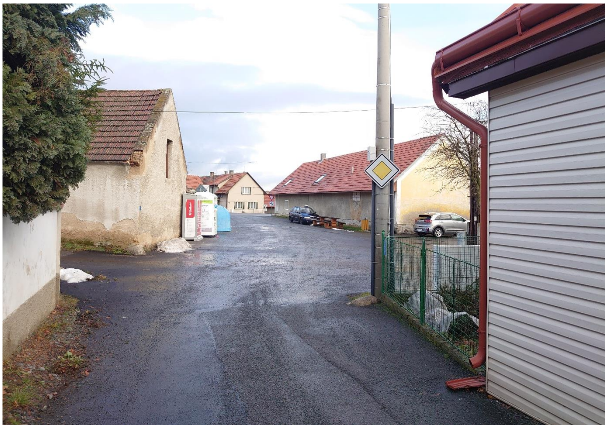
Fotografie č.41 – křižovatka v obytné zóně (místní komunikace „A“ x místní komunikace „B“) u prodejny potravin
