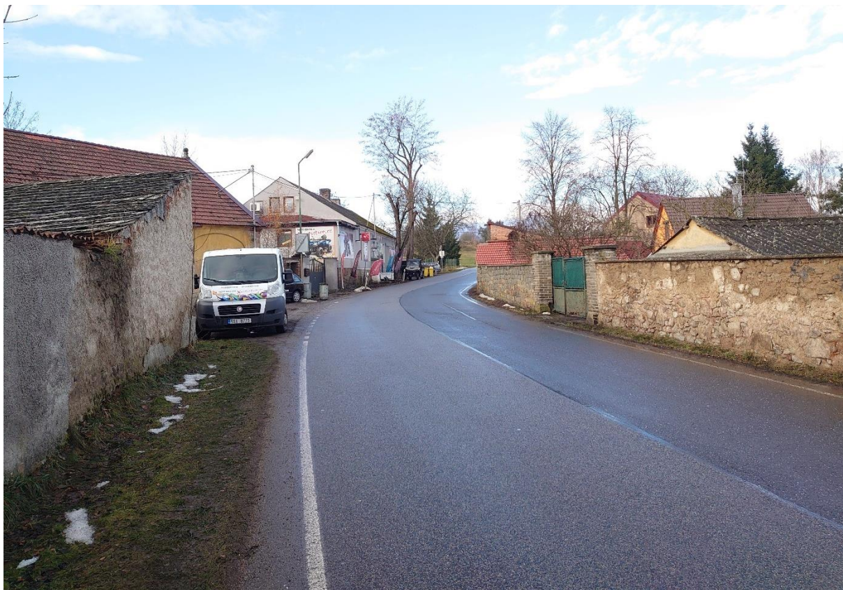
Fotografie č.31 – nevhodně řešená křižovatka průtahu s místní komunikací (Zóna 30), nově výjezd z navrhované obytné zóny (místní komunikace „A“), pohled po směru staničení průtahu
