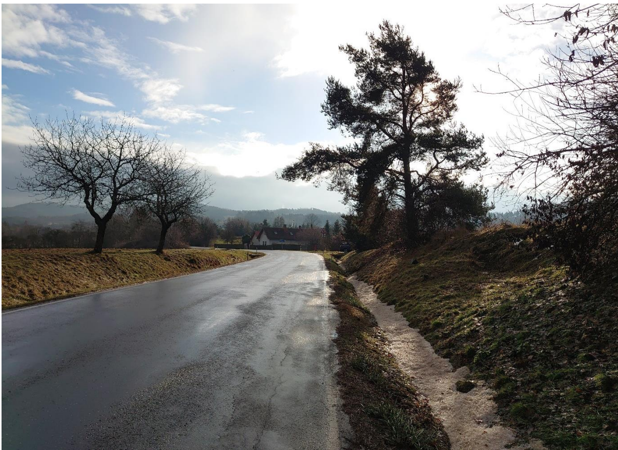
Fotografie č.4 – začátek úseku variant 3, 4 a 5 obchvatu, pohled proti směru staničení (2)
