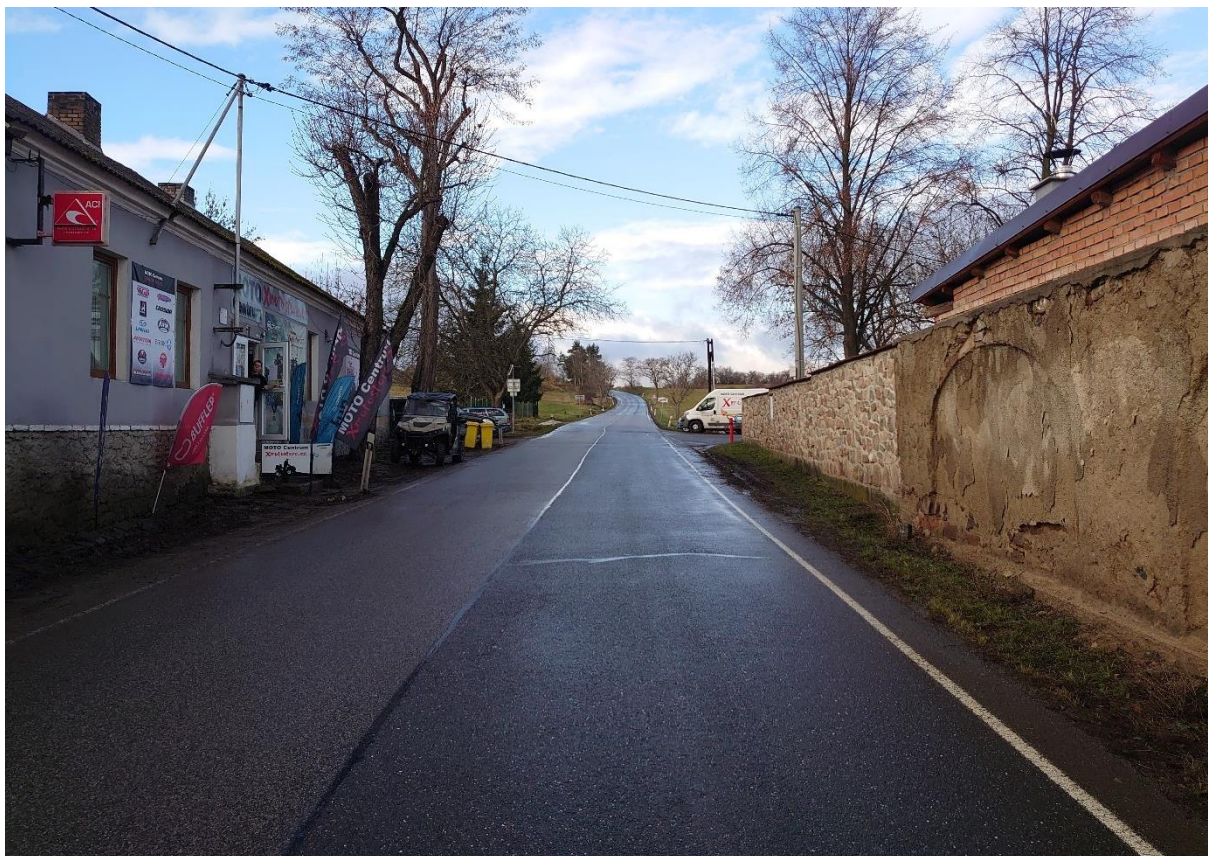
Fotografie č.38 – místo navrhovaného zpomalovacího prahu s integrovaným přechodem pro chodce, pohled po směru staničení
