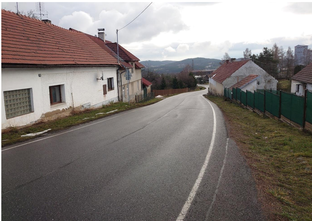
Fotografie č. 18 – místo navrhovaného zpomalovacího prahu s integrovaným místem pro přecházení, pohled proti směru staničení
