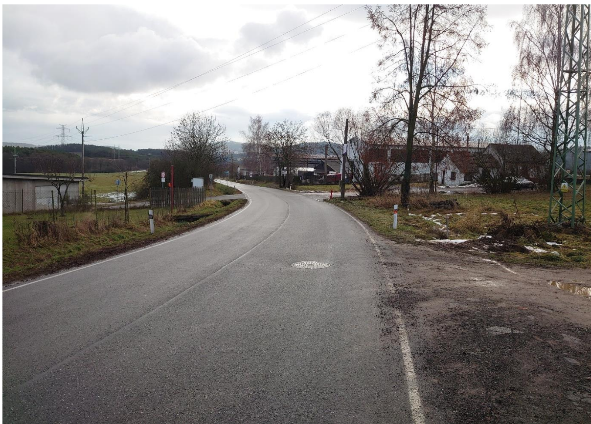
Fotografie č. 14 – místo navrhovaného zpomalovacího prahu s integrovaným přechodem pro chodce, pohled proti směru staničení
