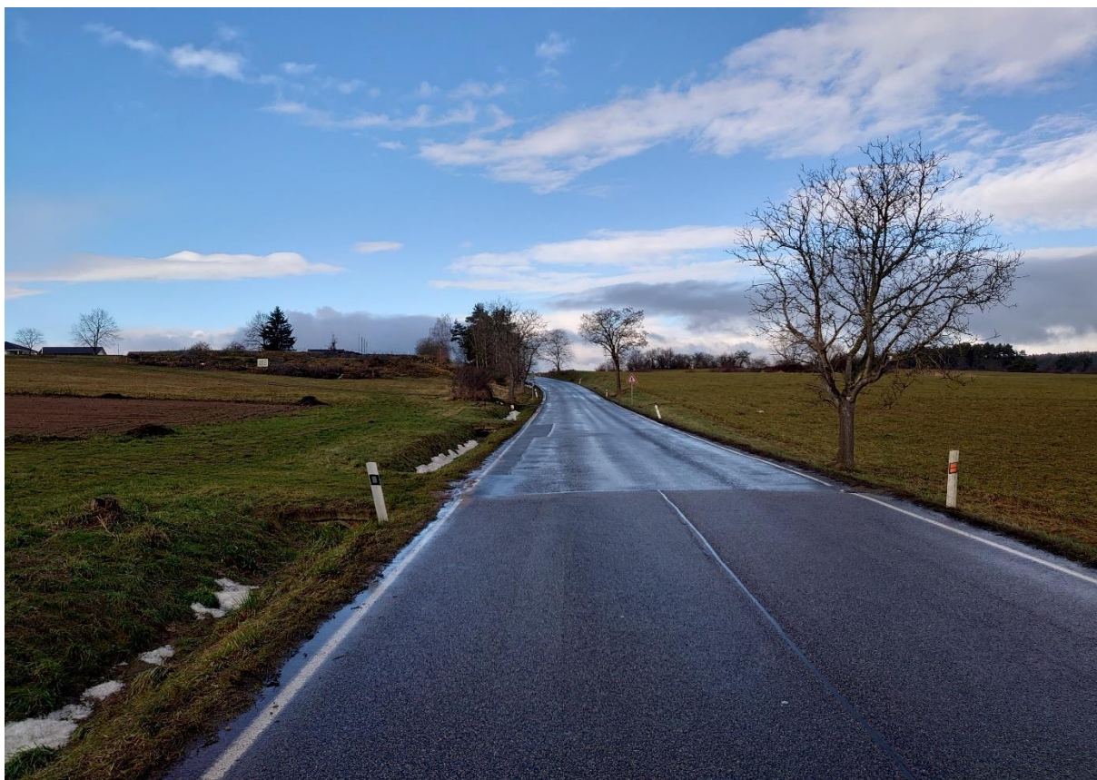
Fotografie č.6 – konec úseku průtahu a začátek úseku opravy vozovky, místo navrhované oboustranné vjezdové brány, pohled po směru staničení
