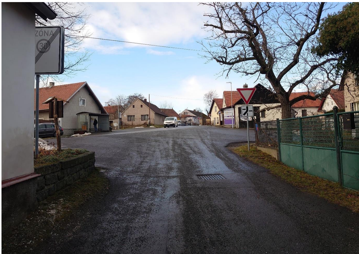
Fotografie č.29 – místní komunikace navazující průtah severovýchodně autobusových zastávek (3)
