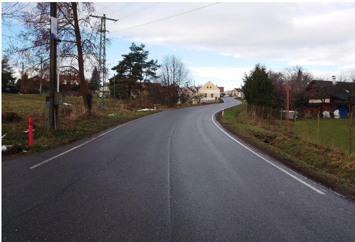
Fotografie č. 14 – místo navrhovaného zpomalovacího prahu s integrovaným přechodem pro chodce, pohled po směru staničení (2)
