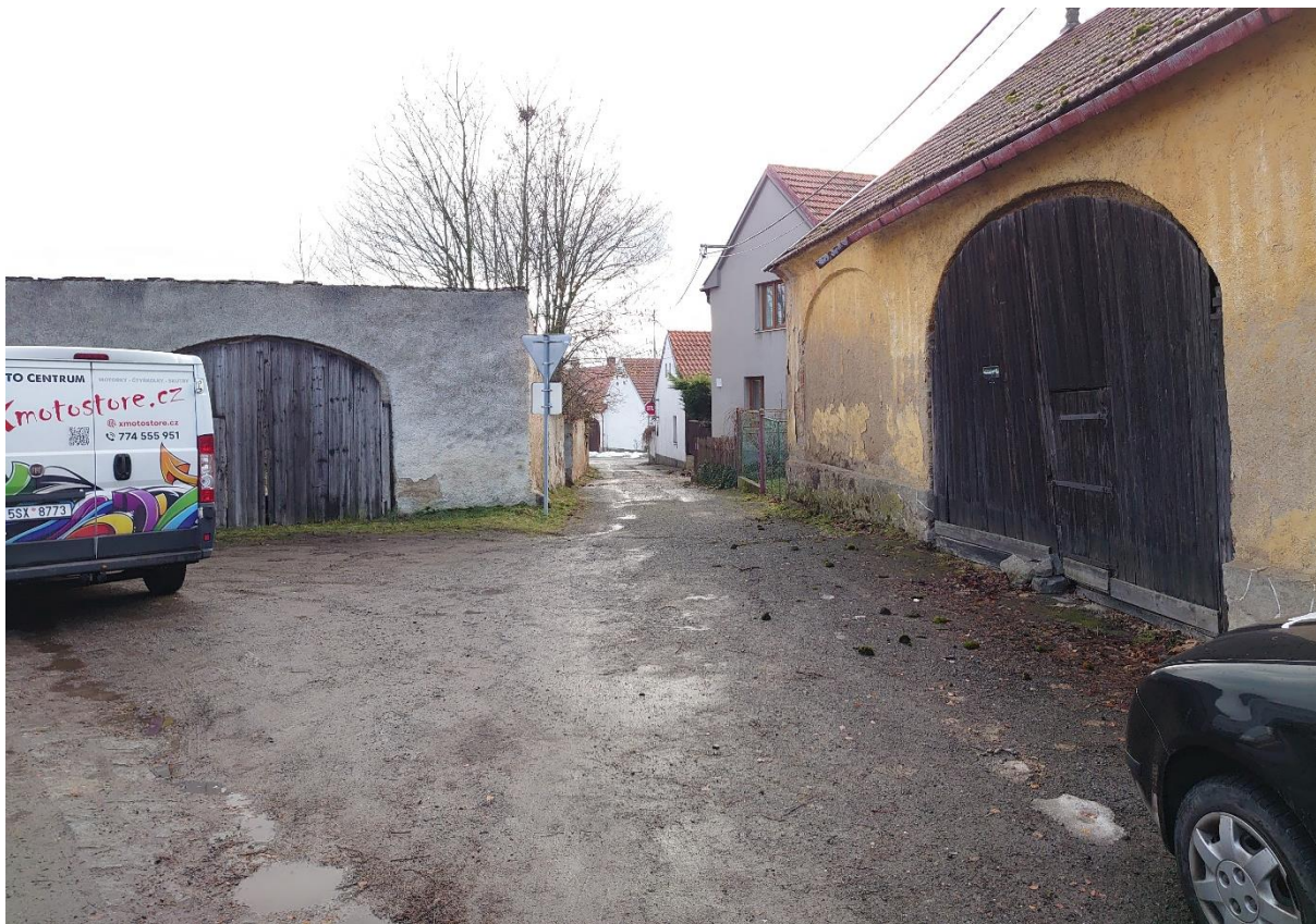
Fotografie č.39 – navrhovaná obytná zóna (místní komunikace „A“), pohled proti směru staničení v místě křižovatky s průtahem
