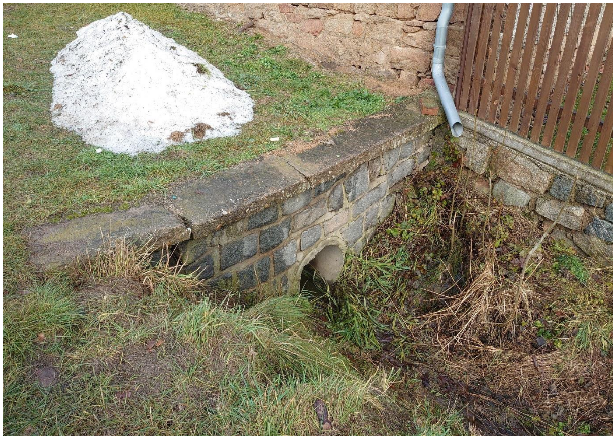
Fotografie č. 17 – vyústění dešťové kanalizace v obci Jablonná – kolmé kamenné čelo
