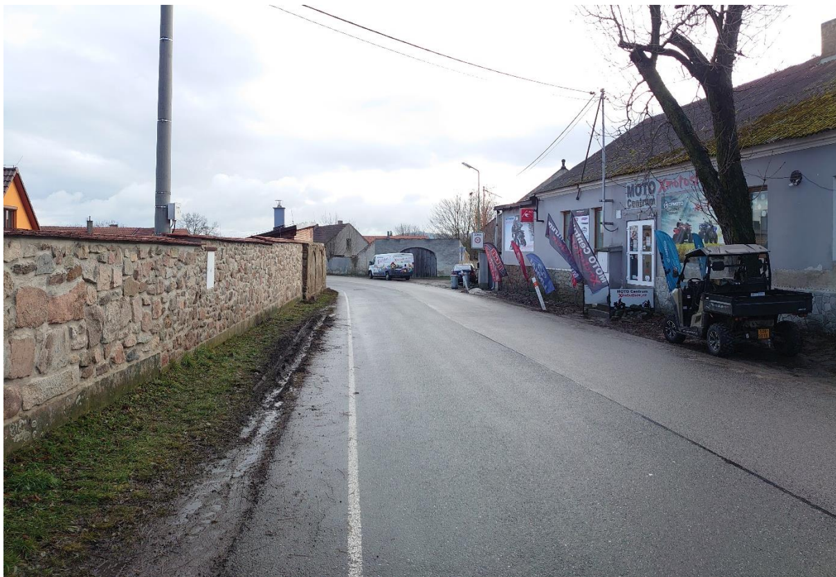
Fotografie č.37 – místo navrhovaného zpomalovacího prahu s integrovaným přechodem pro chodce, pohled proti směru staničení
