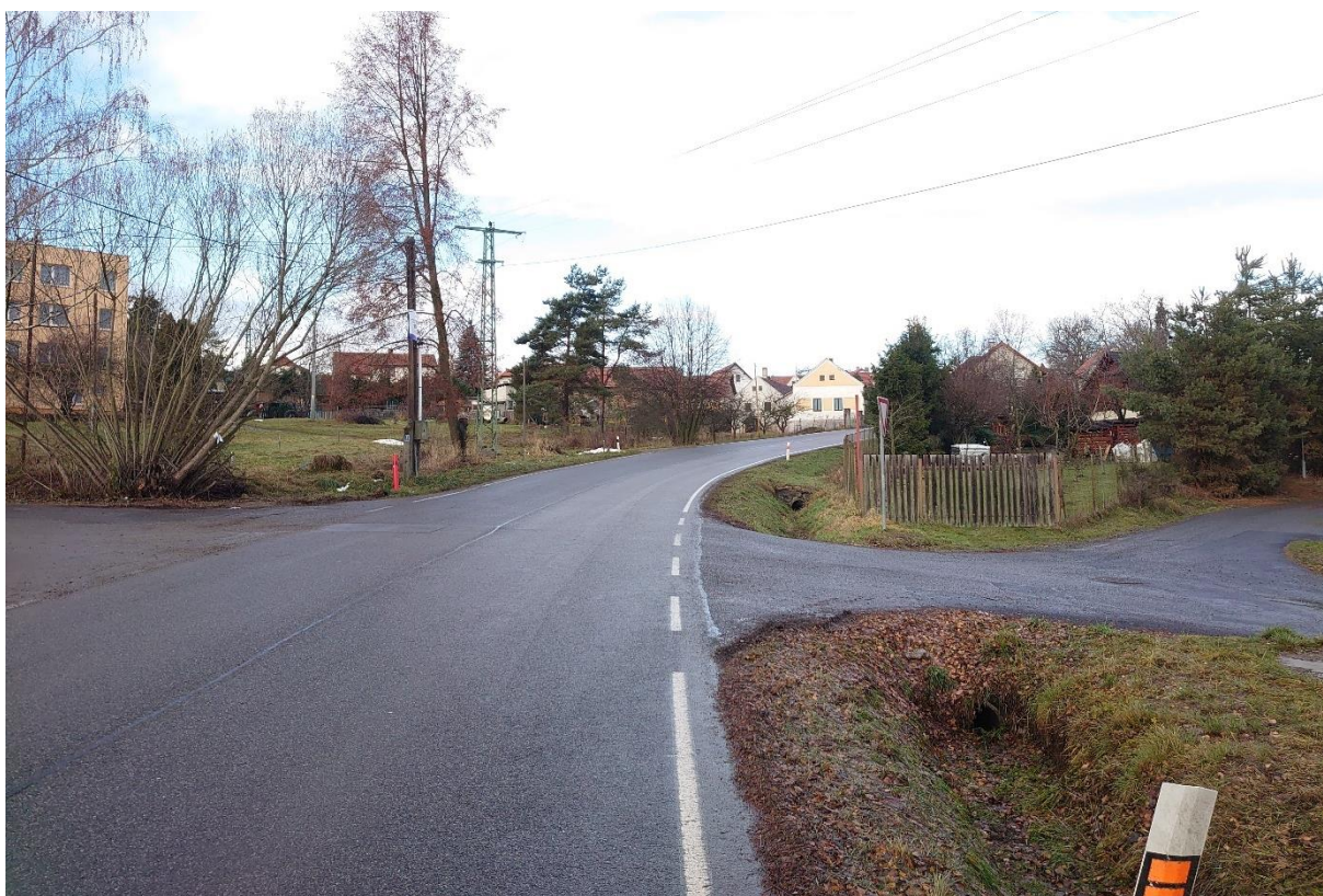
Fotografie č. 14 – místo navrhovaného zpomalovacího prahu s integrovaným přechodem pro chodce, pohled po směru staničení
