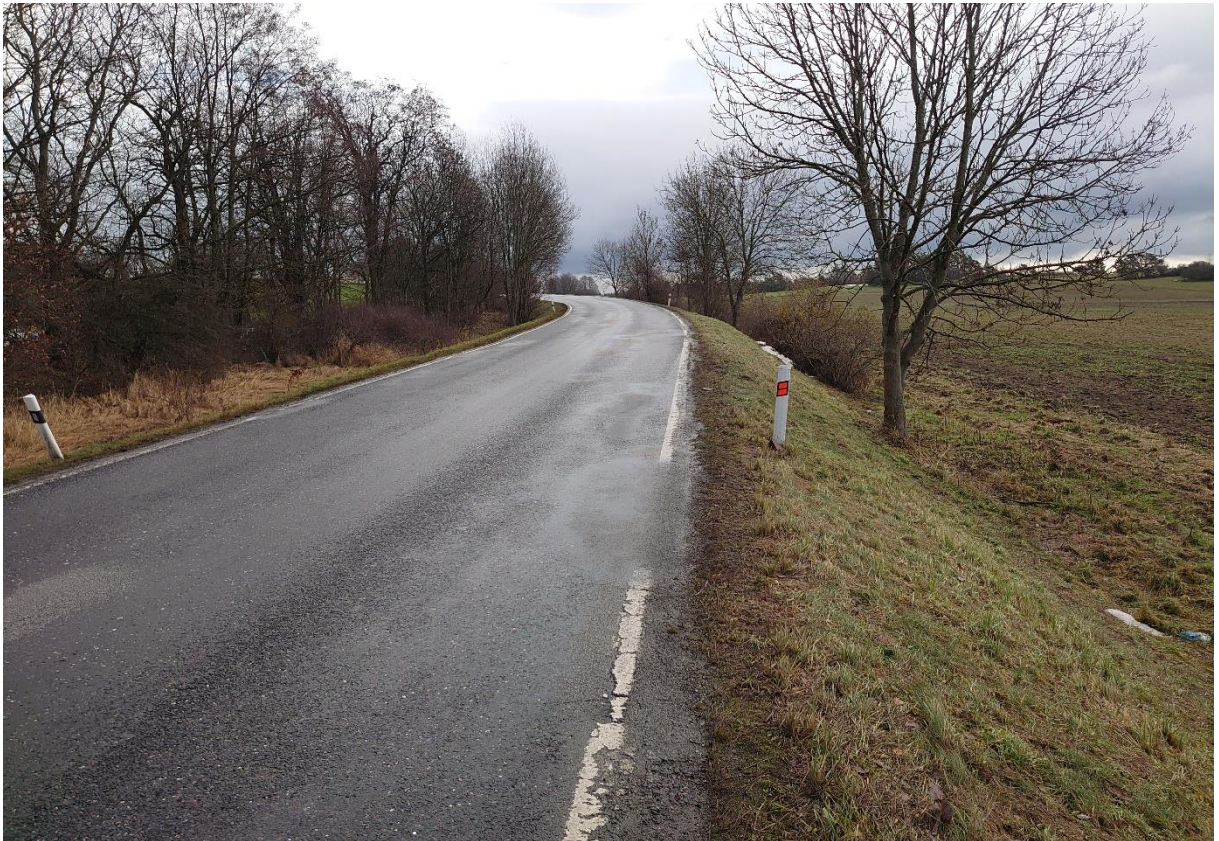
Fotografie č. 11 – konec úseku varianty 5 obchvatu, pohled proti směru staničení
