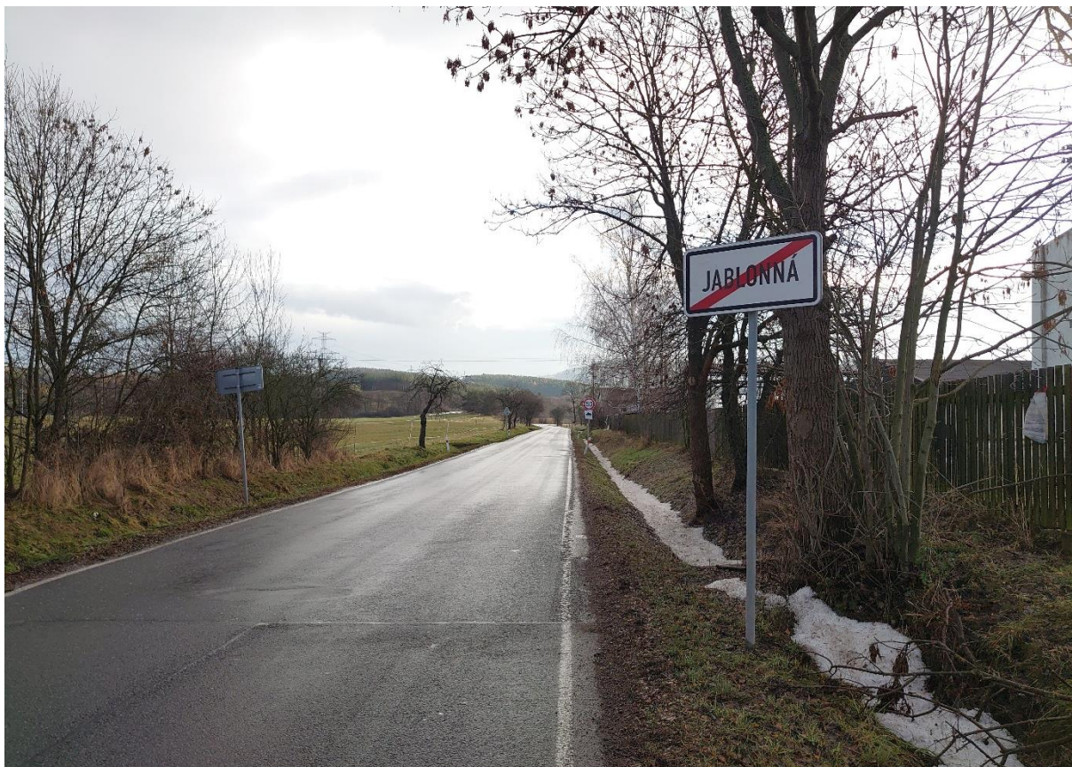
Fotografie č. 13 – konec úseku Komunikace A a začátek úseku průtahu, místo navrhované jednostranné vjezdové brány, pohled proti směru staničení
