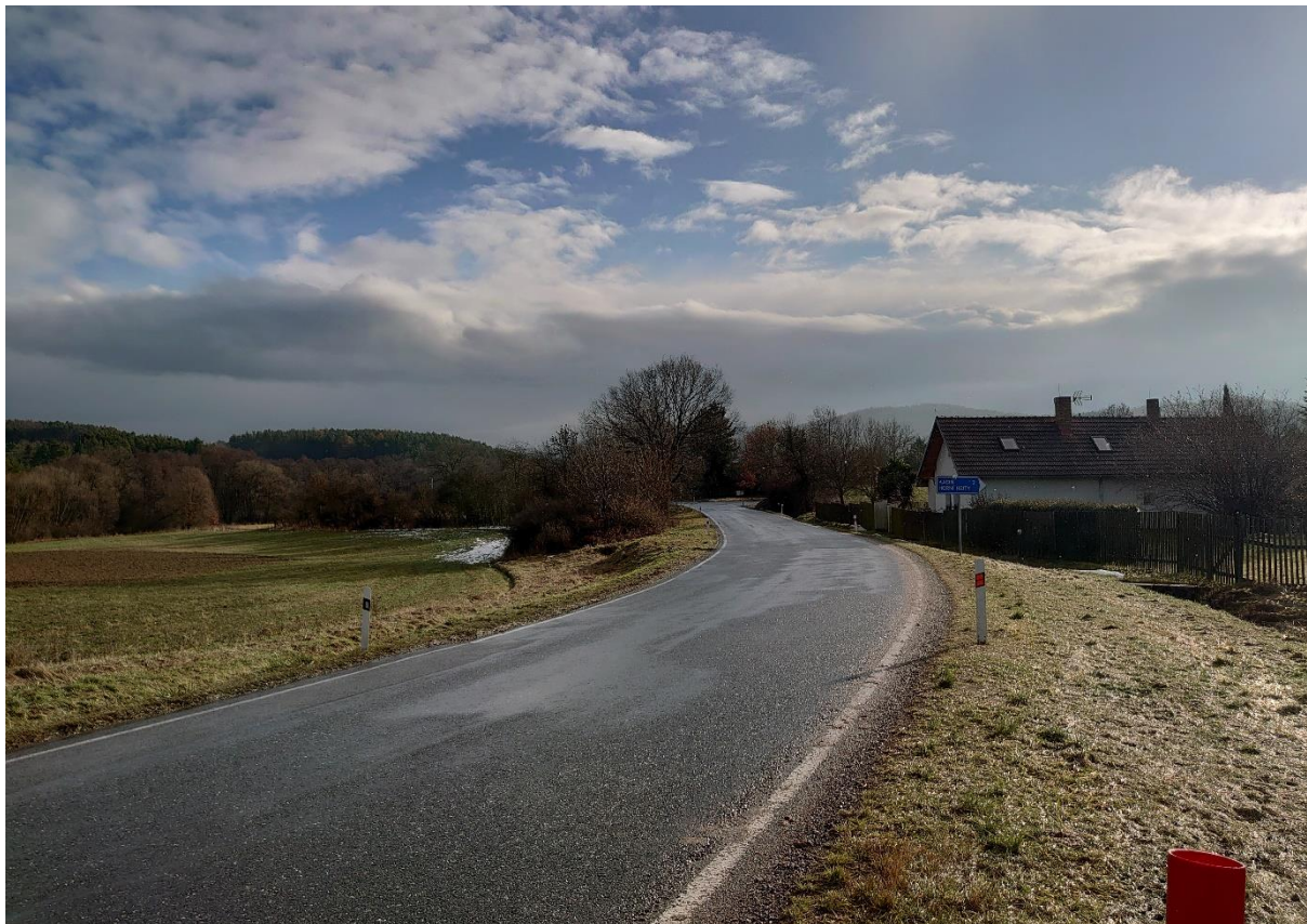
Fotografie č.1 – začátek úseku variant 1 a 2 obchvatu, pohled proti směru staničení
