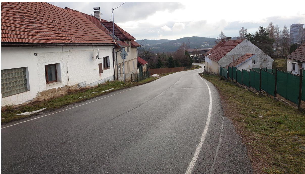
Obrázek č.5 – uliční prostor v obci Jablonná, pohled proti směru staničení
