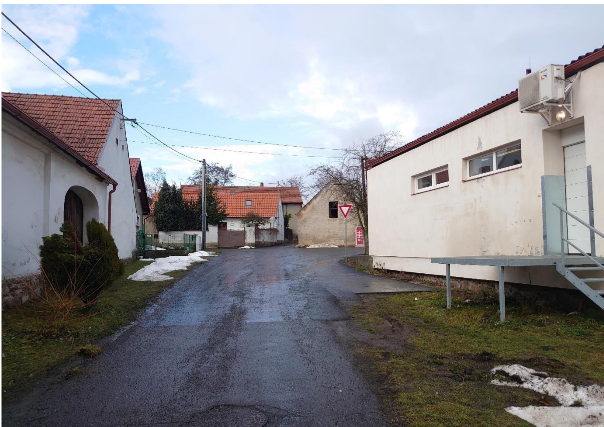
Obrázek č. 11 – zásobovací rampa prodejny potravin, Zóna 30 (Místní komunikace „A“)
