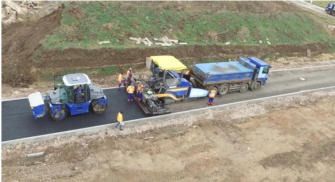
Obrázek 60 - POKLÁDKA A HUTNĚNÍ ACP 32 [vlastní zdroj]
