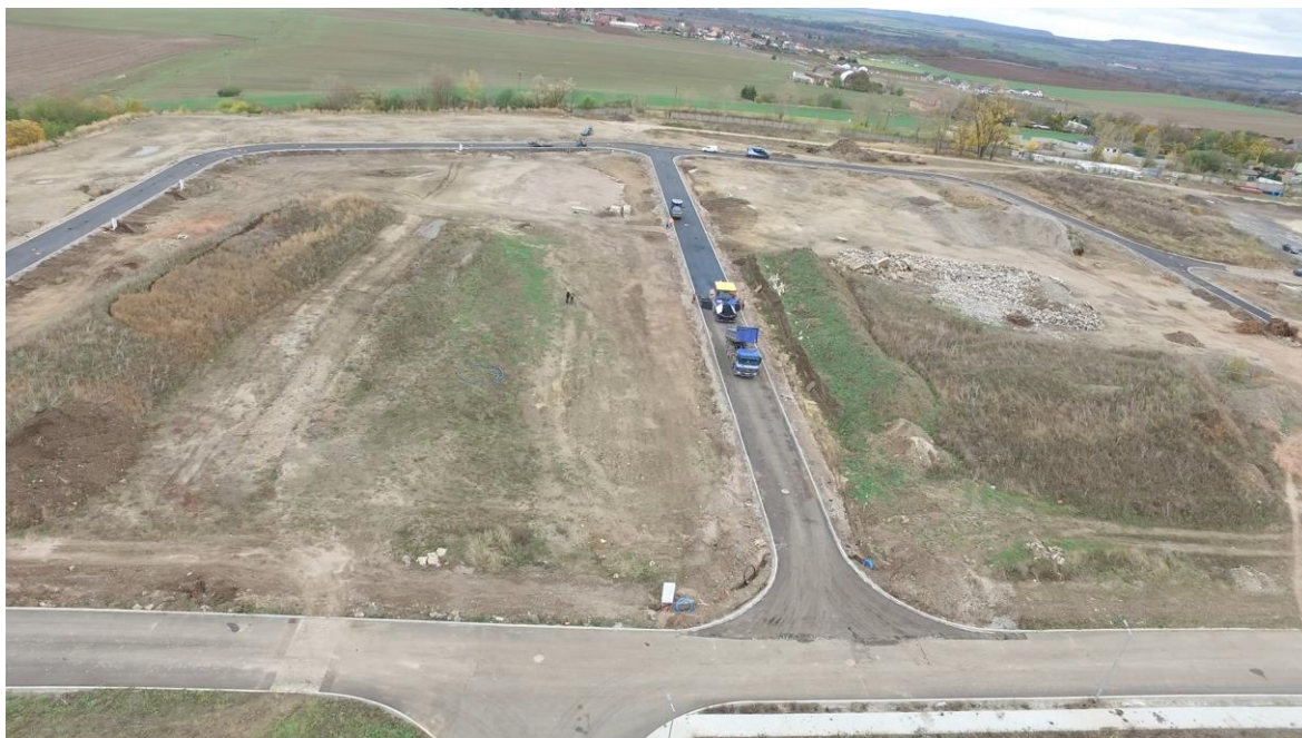
Obrázek 51 – FOTO Z DRONA REALIZOVANÉHO ÚSEKU PODKLADNÍ VRSTVY ACP 32 [vlastní zdroj]
