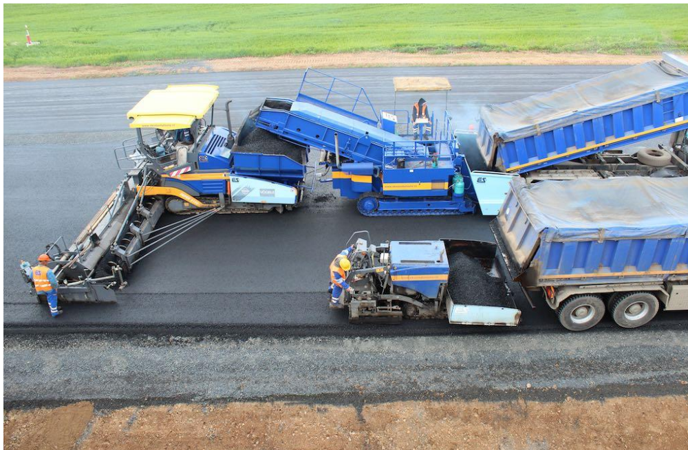
Obrázek 7 - KOMBINACE CHODNÍKOVÉHO FINIŠERU S DÁLNIČNÍM [vlastní zdroj]
