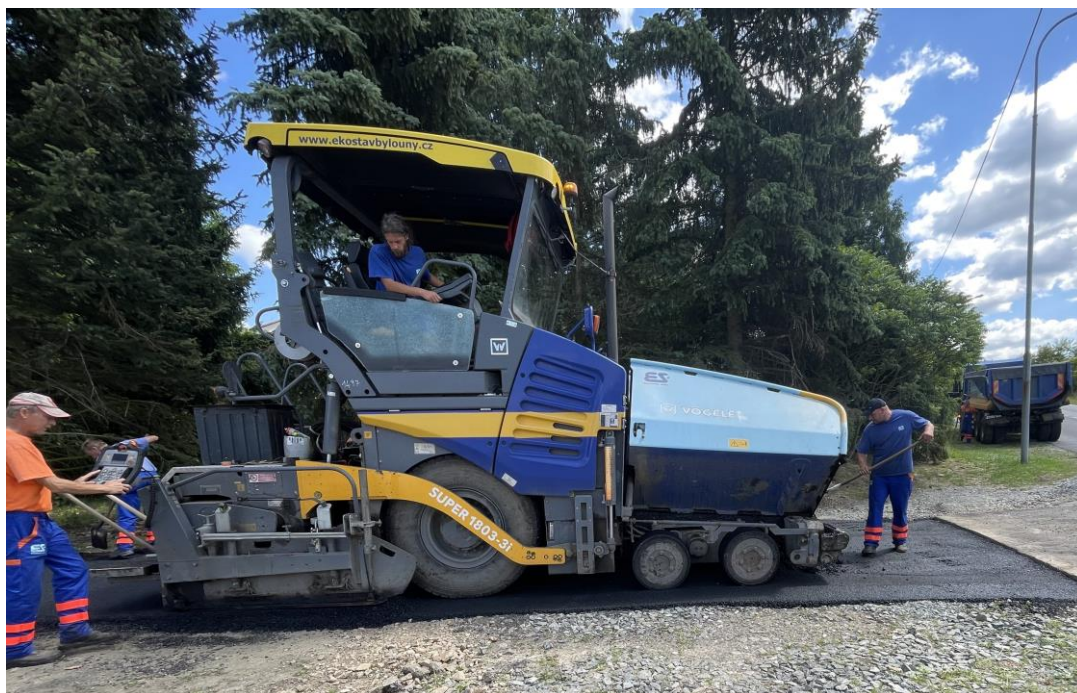
Obrázek 6 - KOLOVÝ FINIŠER VÖGELE SUPER 1803-3i [vlastní zdroj]
