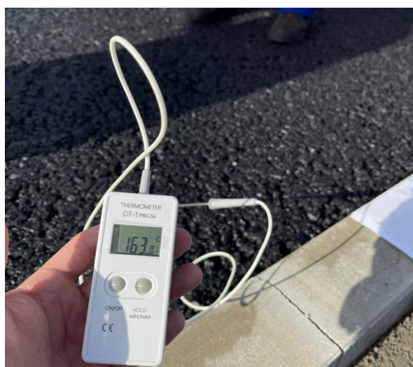
Obrázek 64 - MĚŘENÍ TEPLoty PŘI HUTNĚNÍ [vlastní zdroj]
