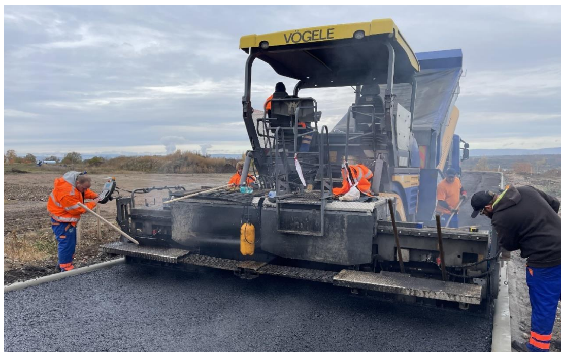
Obrázek 13 - FINIŠER VÖGELE 2100-2 + LIŠTA AB 600 [vlastní zdroj]
