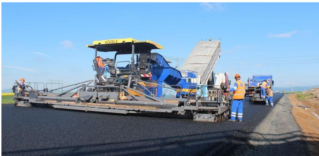
Obrázek 12 - FINIŠER VÖGELE 2100-2 + LIŠTA SB 300 TV S VELKOOBJEMOVOU NÁSYPKOU A PLNÍČÍM VOZEM MT 1000-1 [vlastní zdroj]
