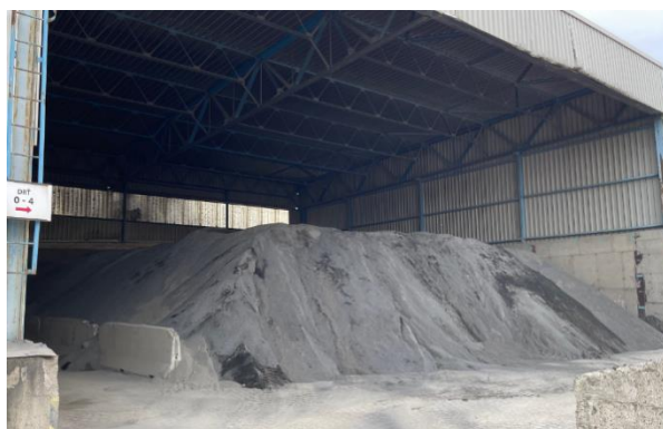
Obrázek 29 – ZASTŘEŠENÉ KAMENIVO FRAKCE 0/4 [vlastní zdroj]
