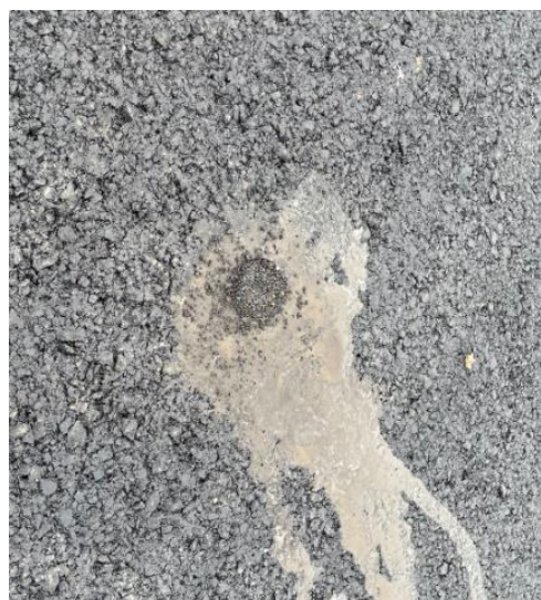
Obrázek 67 - ZATĚSNĚNÍ VRSTVY PO JÁDROVÉM VÝVRTU [vlastní zdroj]
