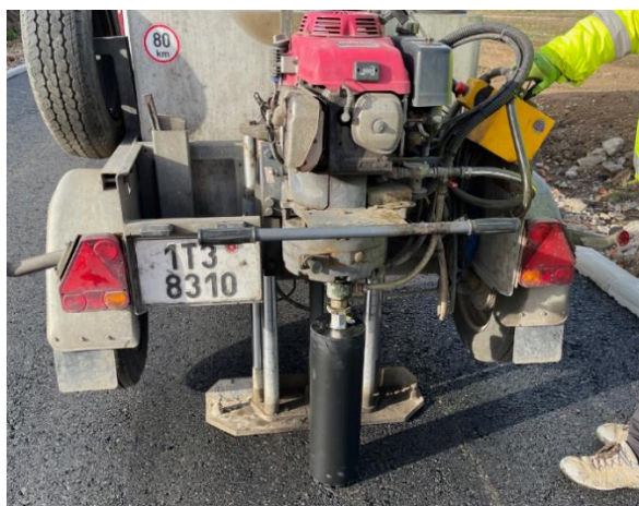
Obrázek 65 - VRTAČKA PRO ZHOTOVENÍ JÁDROVÉHO VÝVRTU [vlastní zdroj]
