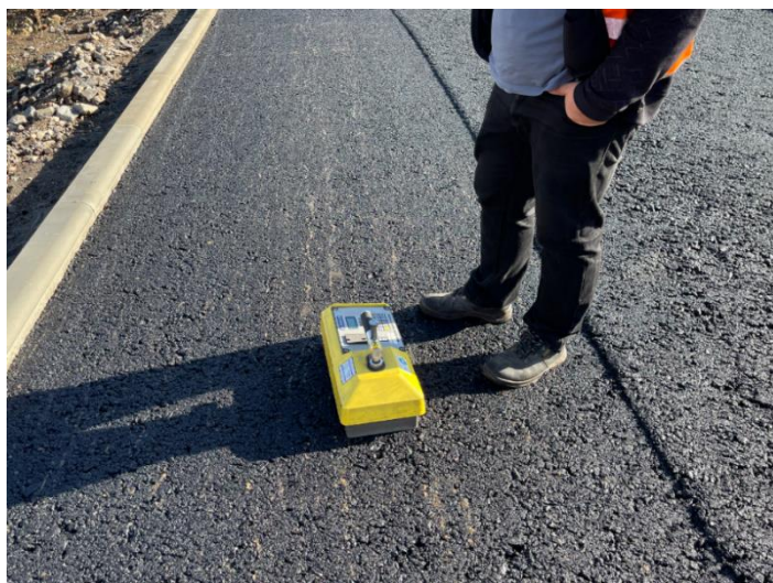
Obrázek 61 - MĚŘENÍ MÍRY ZHUTNĚNÍ PO 1. POJEZDU VÁLCE [vlastní zdroj]
