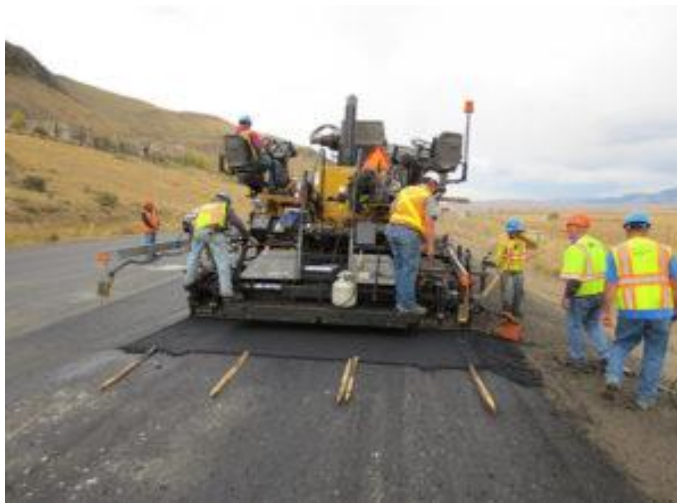
Obrázek 4 - NASTAVENÍ STARTOVACÍ VÝŠKY LIŠTY POMOCÍ DŘEVĚNÝCH HRANOLŮ [13]
