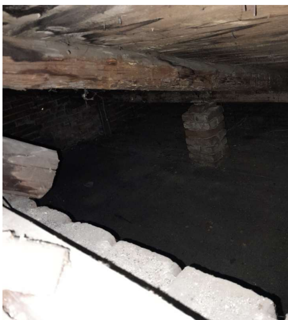
Obrázek 43 – Fotografie podpor střešní konstrukce středního traktu
