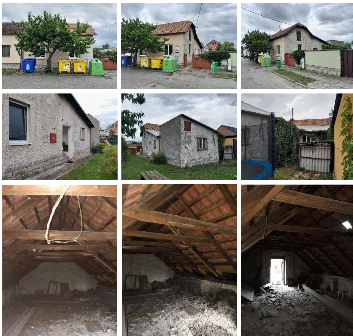
Obrázek 10 – Fotografie objektu a konstrukce krovu sedlové střechy
