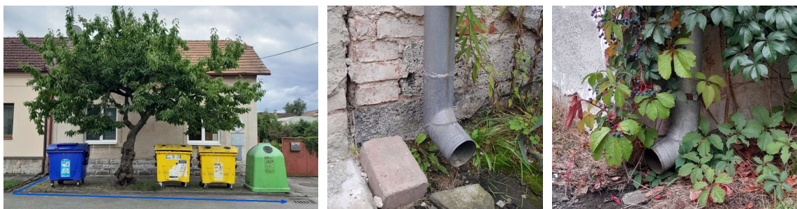
Obrázek 26 – Stávající odvodnění střešních ploch
