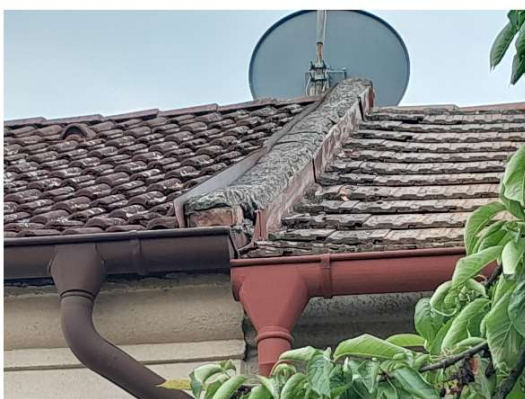
Obrázek 55 – Fotografie a schéma nadezdívky střešního pláště
