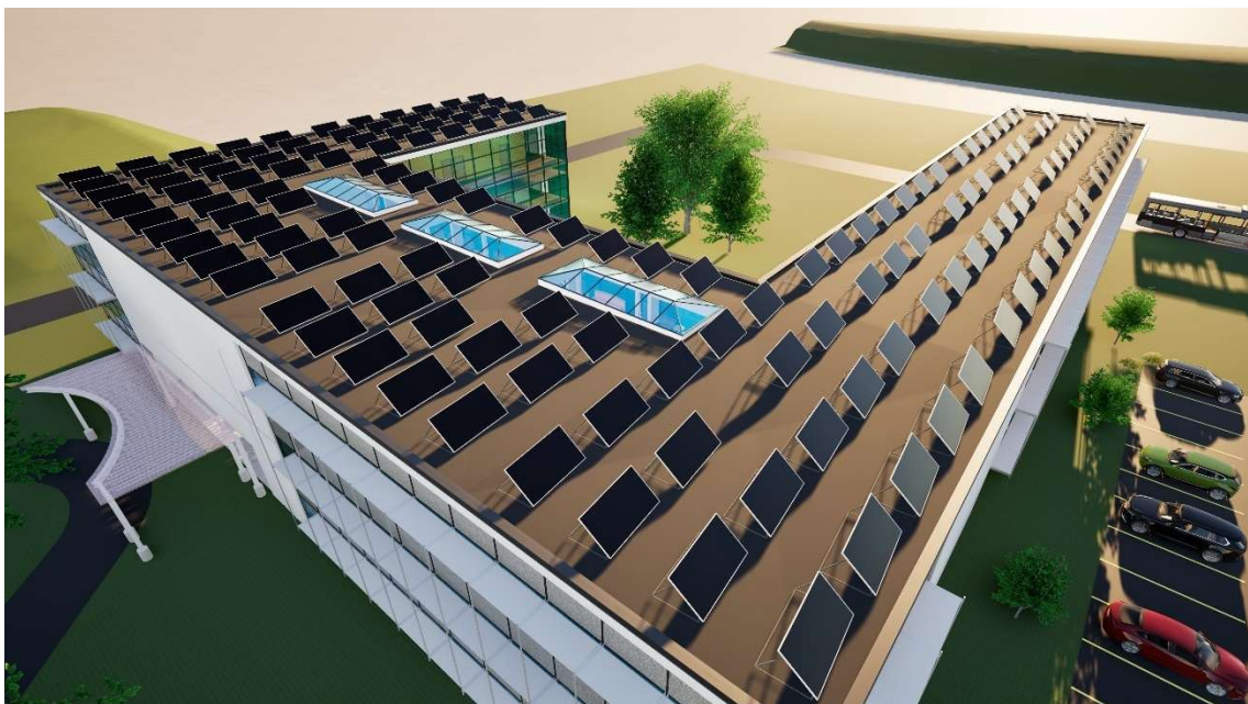
Obr. 16 – Školní budova: umístění fotovoltaických panelů na střechě
