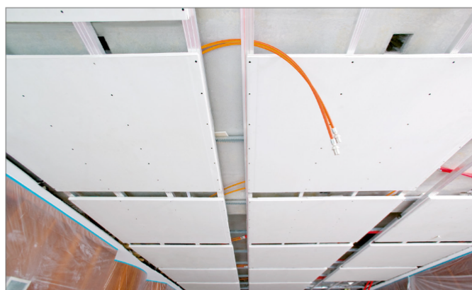
Obr. 6-7 REHAU systém stropního vytápění / chlazení - suchý způsob
