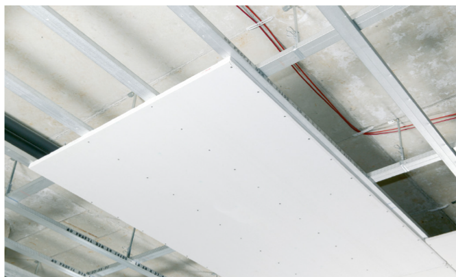
Obr. 6-14 Namontovaná stropní deska
