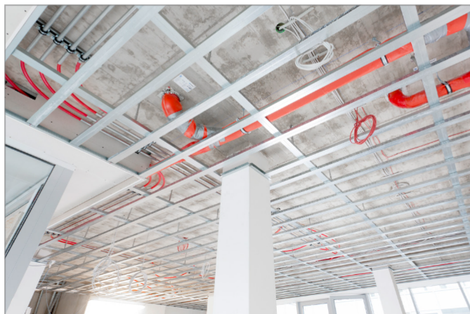
Obr. 6-22 Připravená konstrukce pohledu
