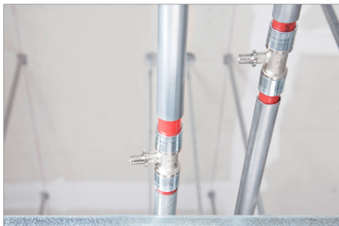
Obr. 6-23 Připravené T-kusy pro napojení stropních desek
