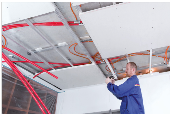
Obr. 6-24 Propojení připojovacího potrubí
