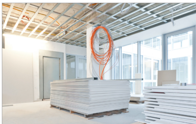
Obr. 6-10 Paleta se stropními deskami
