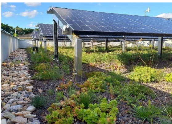
Obrázek 54: Realizace biosolární střechy [44]
