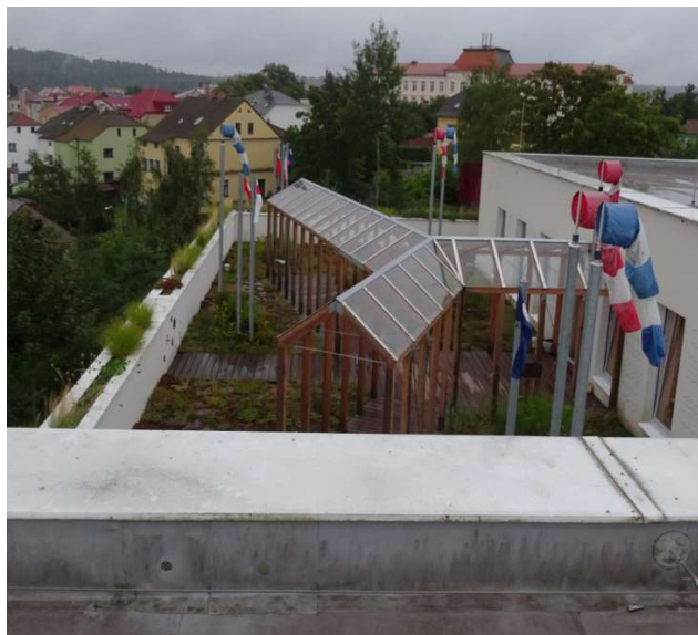
Obrázek 5, Zelená pochozí střecha v pravé části budovy
