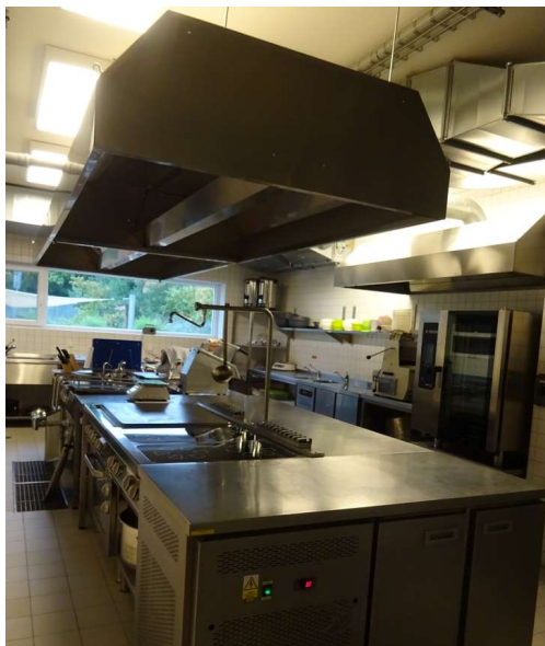
Obrázek 32, Zařízení pro odvod páry - digestoř
