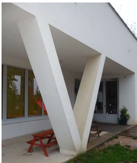
Obrázek 3, Sloupy do tvaru V u vstupních dveří objektu
