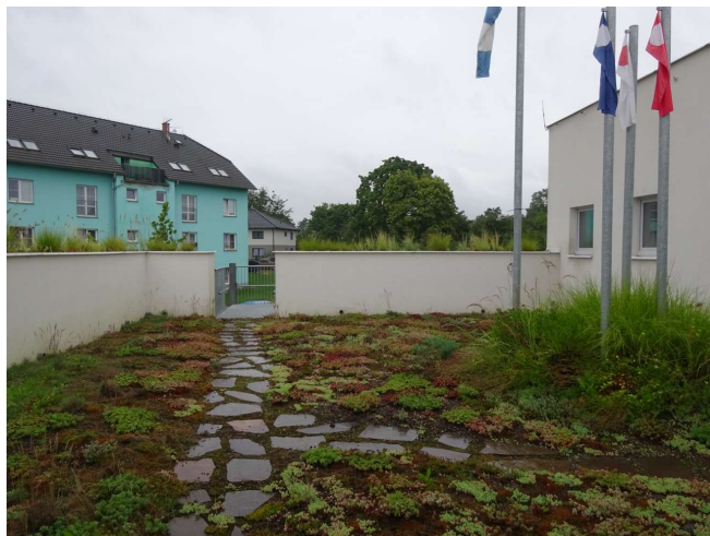
Obrázek 4, Zelená pochozí střecha v levé části budovy
