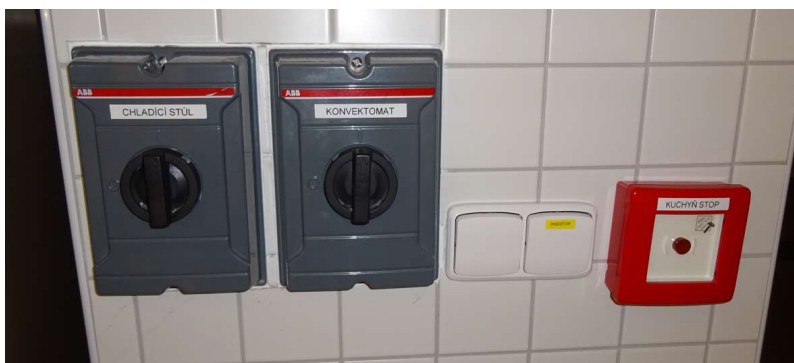
Obrázek 9, Tlačítko pro zastavení provozu s ostatními ovládacími prvky v kuchyni
