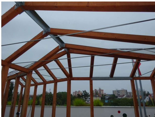
Obrázek 26, Dřevěná konstrukce se střechou na zelené střěše
