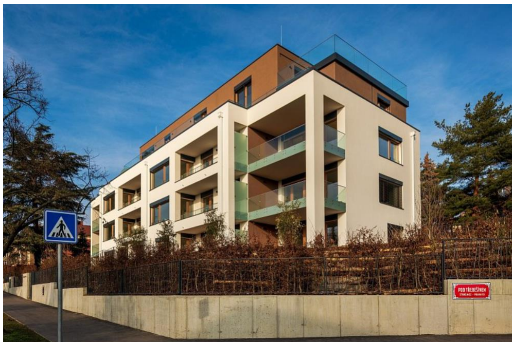
Obrázek 3.1: pohled na dokončenou výstavbu bytového domu
