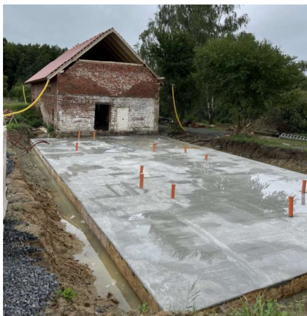
Obrázek 12: Základová deska v místě zbourané stodoly
