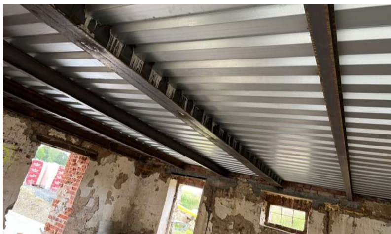
Obrázek 14: Nová ocelová stropní konstrukce ve stávající části objektu
