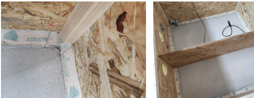
Obrázek 62 Betonová podlaha na konci 2. fáze
