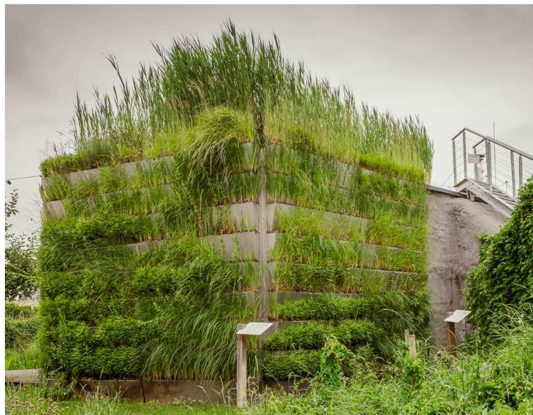
Obrázek 3 - Fasádní kořenová čistička [16]
