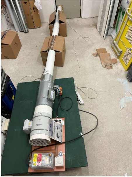
Obr. 17) Část modelu s plastovým potrubím umístěná v první části místnosti A-s114
