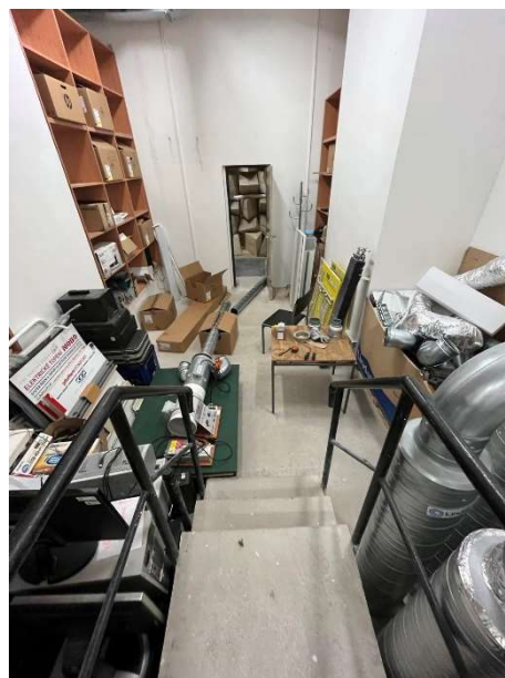
Obr. 5) Příprava podpory potrubí
