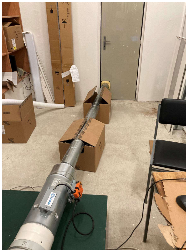
Obr. 2) První část místnosti A-s114 s prostupem izolovaným akustickým molitanem
