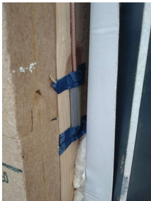
obrázek 4.3.9 - vypěnění spáry s vytvořenou dutinou (měřeno čidlem) d)
