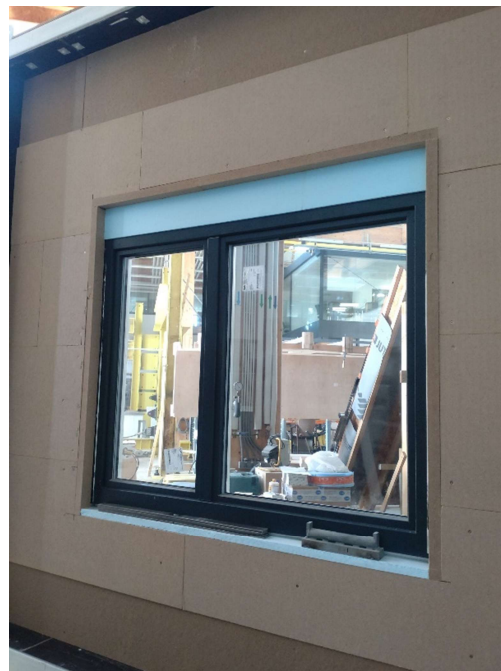
obrázek 4.3.14 - nalepení XPS b)
