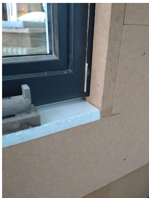
obrázek 4.3.15 - detail parapetu s přitížením b)
