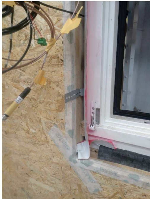
obrázek 4.3.7 - detail s kotvou, illbruck folií, nosnou podložkou; dále detail aplikace Airstop pásky b) a c)
