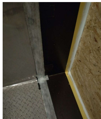
obrázek 5.1.6 - detail přelepené spáry
