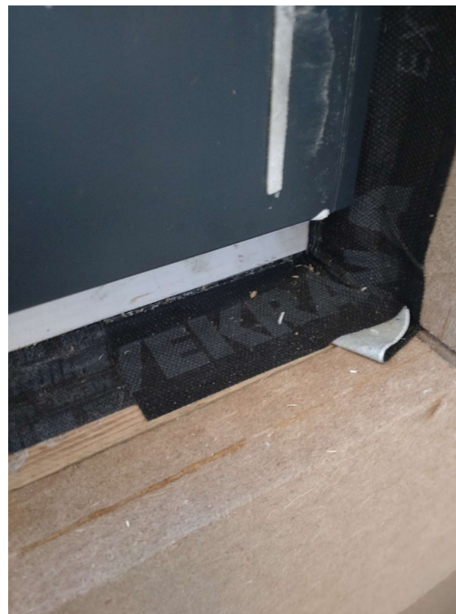
obrázek 4.3.10 - detail nalepené vnější folie
