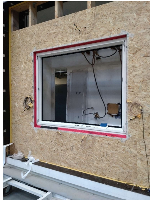
obrázek 4.3.8 - pohled na připevněné okno s nalepenou vnitřní folií c)
