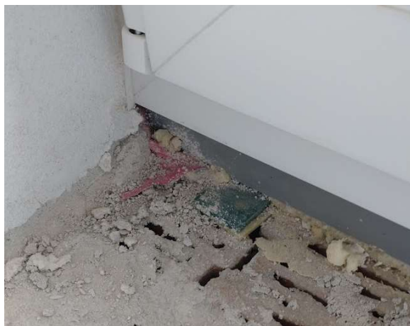
obrázek 2.2.1 - chybný detail parotěsné folie (zdroj: archiv autora)
