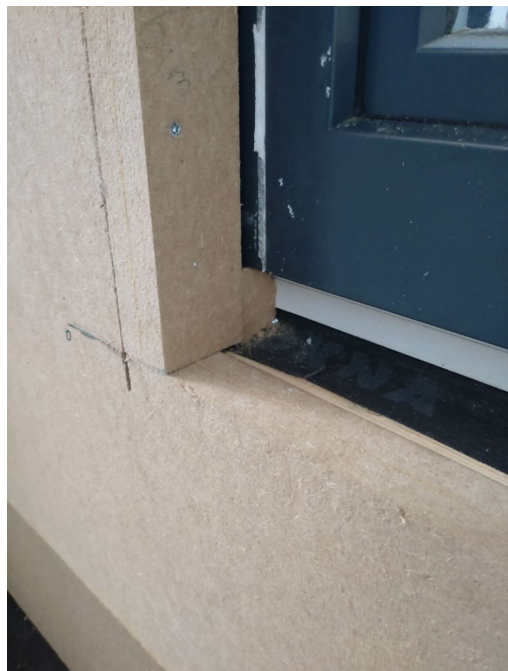
obrázek 4.3.13 - detail ostění se Steico a)
