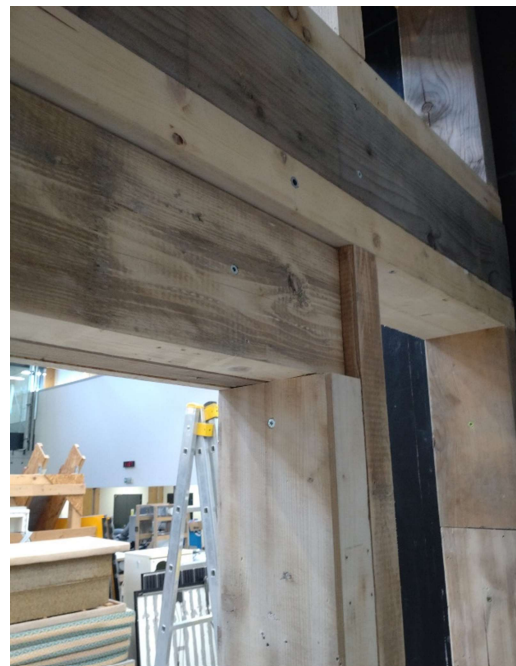
obrázek 4.3.4 - detail překladu
