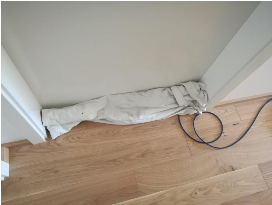
Obr. 9.09: Prekrytie gumového tesnenia textíliou
