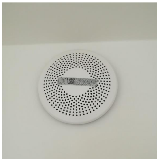
Obr. 9.06: Tanierová výustka v obytných miestnostiach
