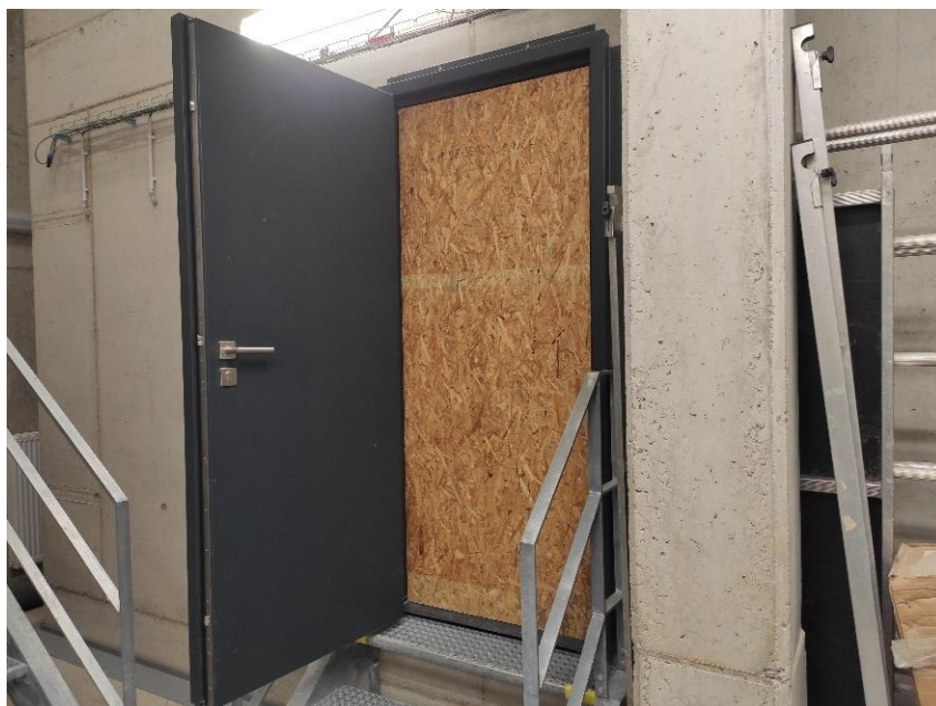
Obr. 10.07: OSB doska ako výplň dverového otvoru
