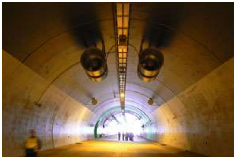
Obr. 9 Podélně větrání tunelů [25]
