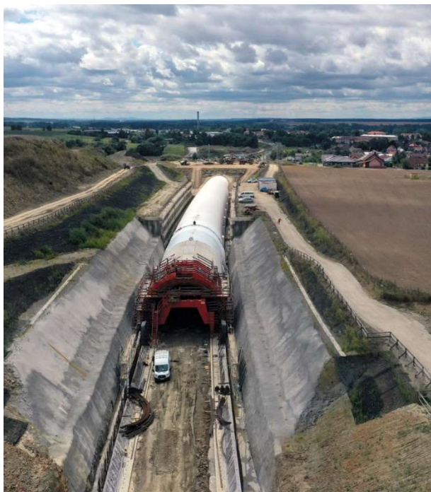
Obr. 1 Hloubený tunel Zvěrotice [7]
