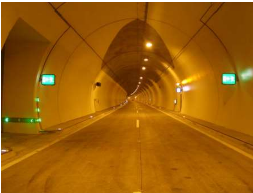
Obr. 6 Silniční tunel Strenger s ostěním z monolitického betonu [17]
