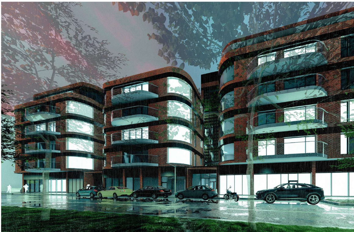
Obrázek 5 - Řešený bytový dům: SV pohled [7]
