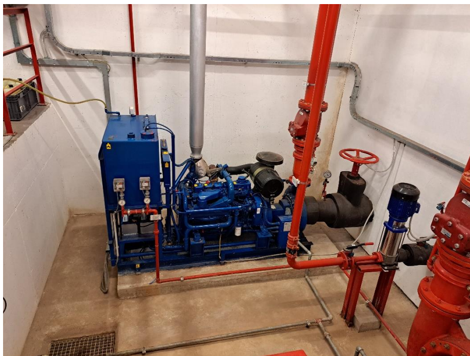
Obrázek 2 - Čerpadlo s dieselovým motorem
