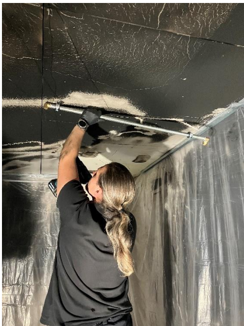
Obrázek 19 - Montáž trubky
