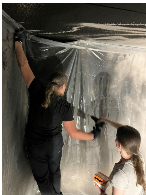
Obrázek 17 - Montáž fólie
