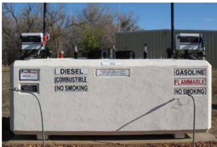
Obrázek 4 – Železobetonová nádrž na palivo [36]
