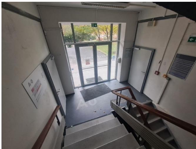
Obr. 74 — Nový stav dveří v 1.PP (stav k 20.11.2023)
