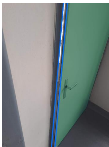
Obr. 49 — Netěsnost dveří v realitě
