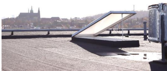
Obr. 79 — Otevřený samočinně otevíratelný světlík při simulaci požární situace [3]
