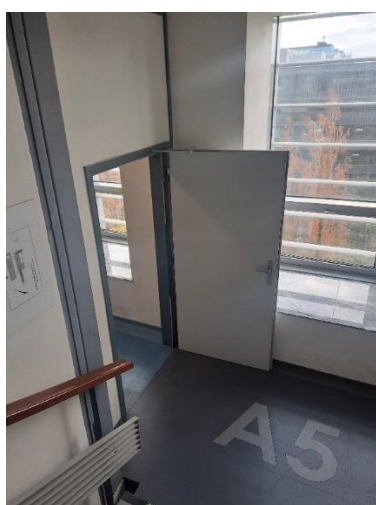
Obr. 101 — Zajištěné dveřní křídlo 5.NP
