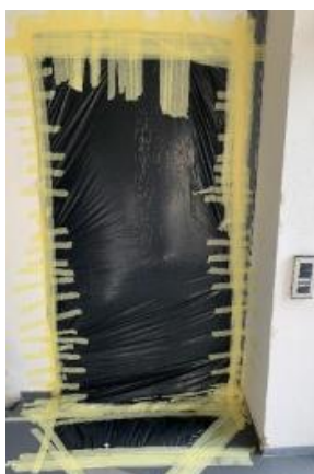
Obr. 48 — Utěsnění dveří 1.PP [3]
