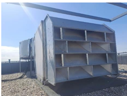
Obr. 23 — Fotografie zakrytování ventilátoru (nasávací otvory)
