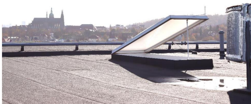
Obr. 29 — Otevřený světlík [3]
