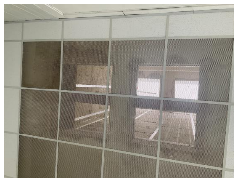
Obr. 28 — Šachta světlíku (pohled z mezipodesty 13. NP)
