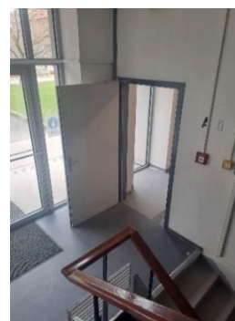
Obr. 17 — Dveře, zabráněno zavření (1.PP)
