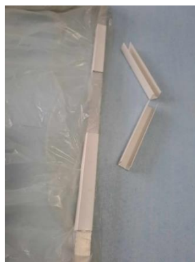
Obr. 71 — Uchycení pomocí PVC – U profilu
