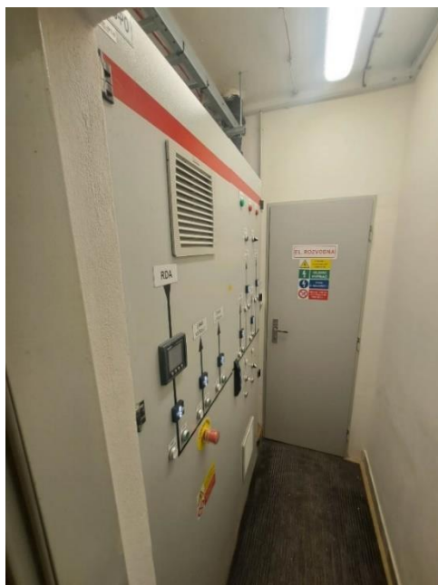
Obr. 25 — Požární rozvodna
