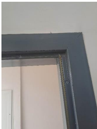
Obr. 20 — Chybějící těsnění na zárubni (2.NP)
