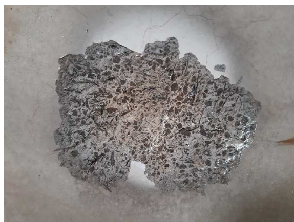
b) Panel po zkoušce
