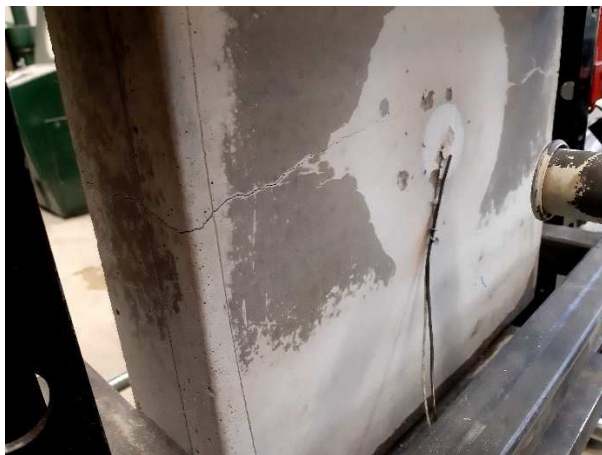
a) Panel po zkoušce
