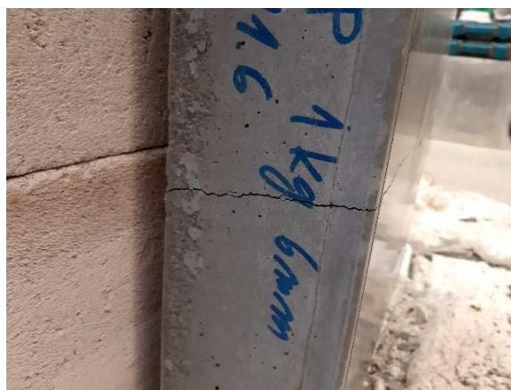
b) Panel po zkoušce
