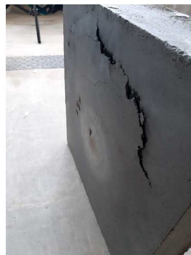
b) Panel po zkoušce
