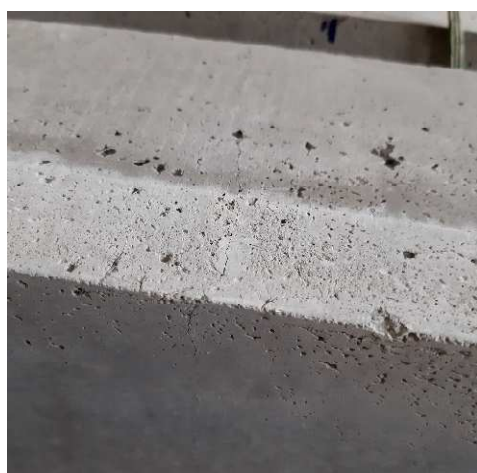
a) Panel po zkoušce
