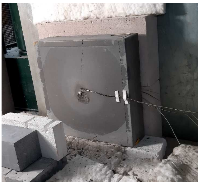
a) Panel po zkoušce
