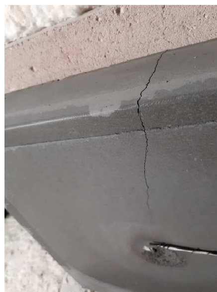
b) Panel po zkoušce
