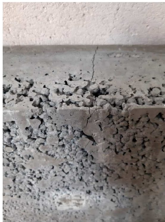
b) Panel po zkoušce
