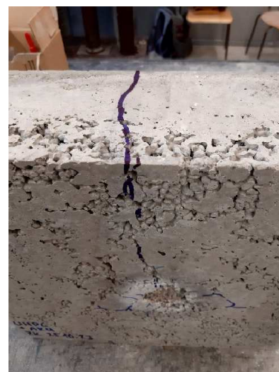
b) Panel po zkoušce
