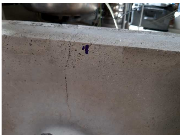
a) Panel po zkoušce
