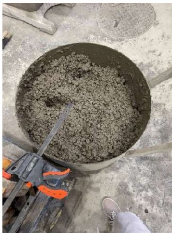
Obrázek 41 Hotová namíchaná betonová směs na betonáž
