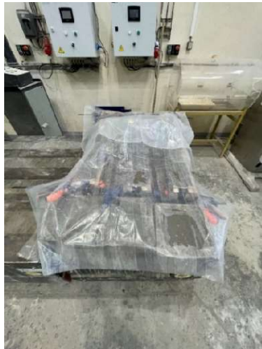
Obrázek 57 Přikrytí čerstvého betonu folií
