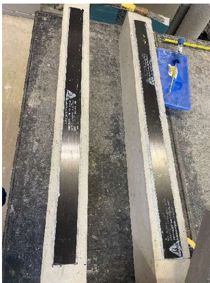
Obrázek 60 Dva dodatečně zesílené nosníky
