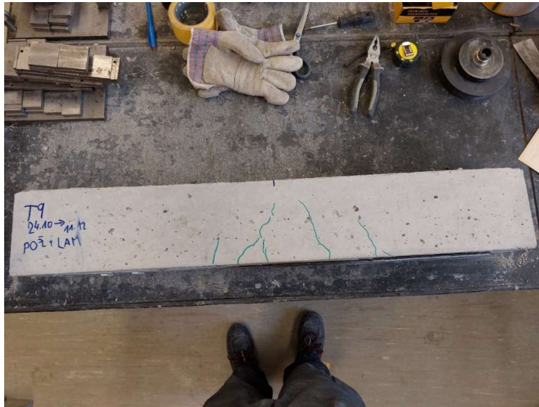
Obrázek 75 Nosník T9 po provedení zkoušky s vyznačením vzniklých trhlin
