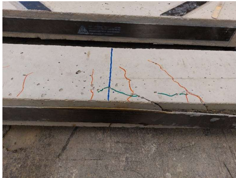
Obrázek 68 Detail nosníku T7
