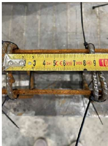
Obrázek 40 Vzdálenost třmínků na osu cca 90mm
