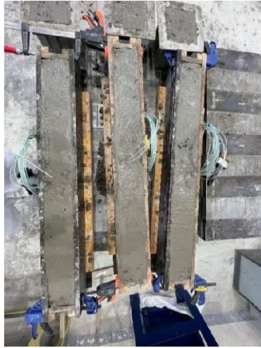
Obrázek 56 Konečné zalití bednění betonem
