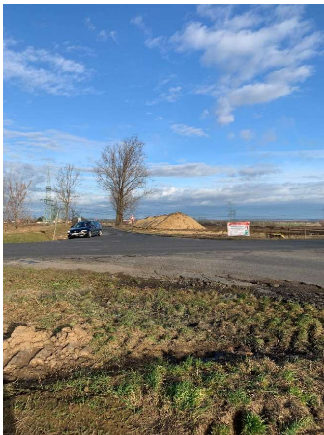
Fotografie 14 Pohled na budoucí okružní křižovatku
