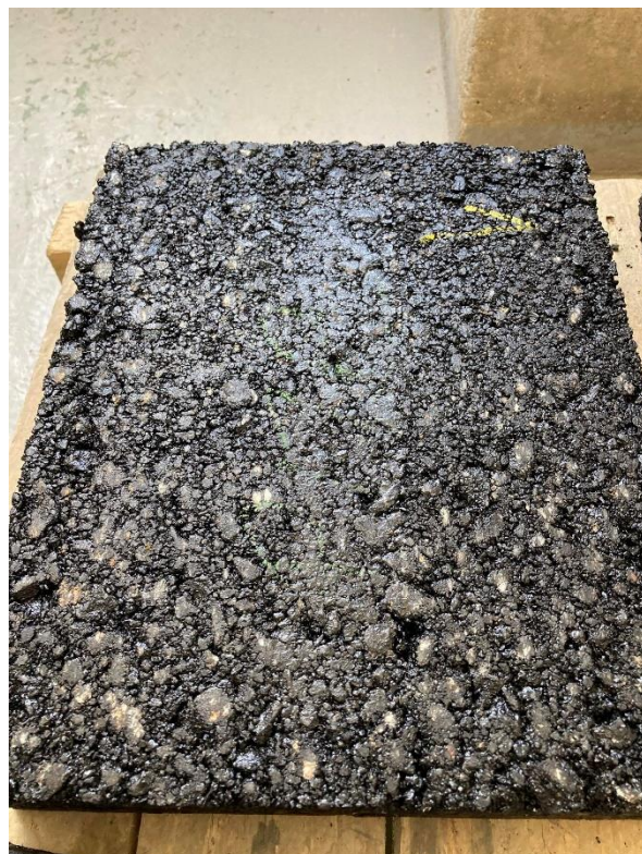
Obrázek 34 Deska po skončení zkoušky [23]
