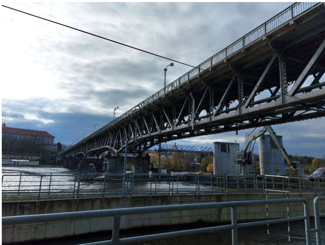
Obrázek 25 – nosná konstrukce mostu
