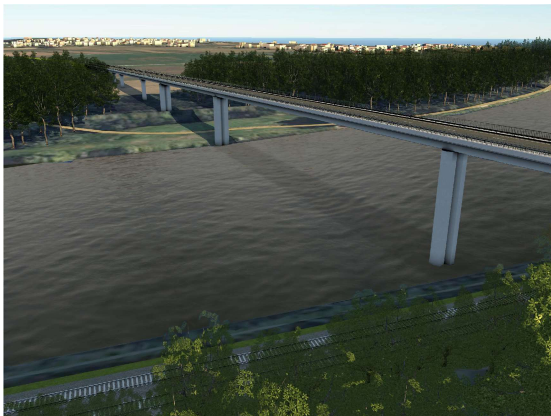
Obrázek 16 – pohled na most, v popředí železniční trať a v pozadí Vědomice
