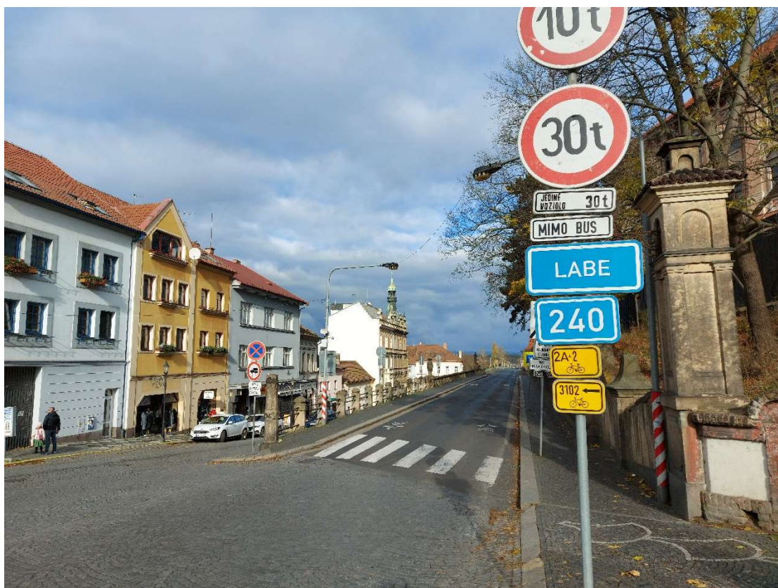
Obrázek 26 – napojení mostu na Karlovo náměstí
