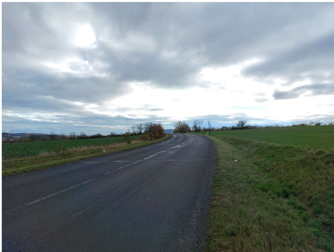
Obrázek 1 – pohled na ZÚ proti směru staničení
