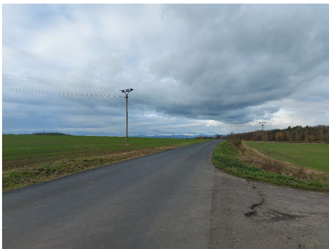
Obrázek 4 – pohled na III/24616 a místo budoucího přemostění
