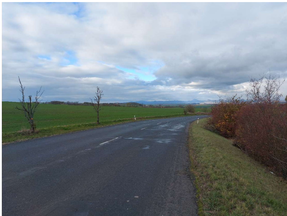
Obrázek 2 – pohled od ZÚ ve směru staničení
