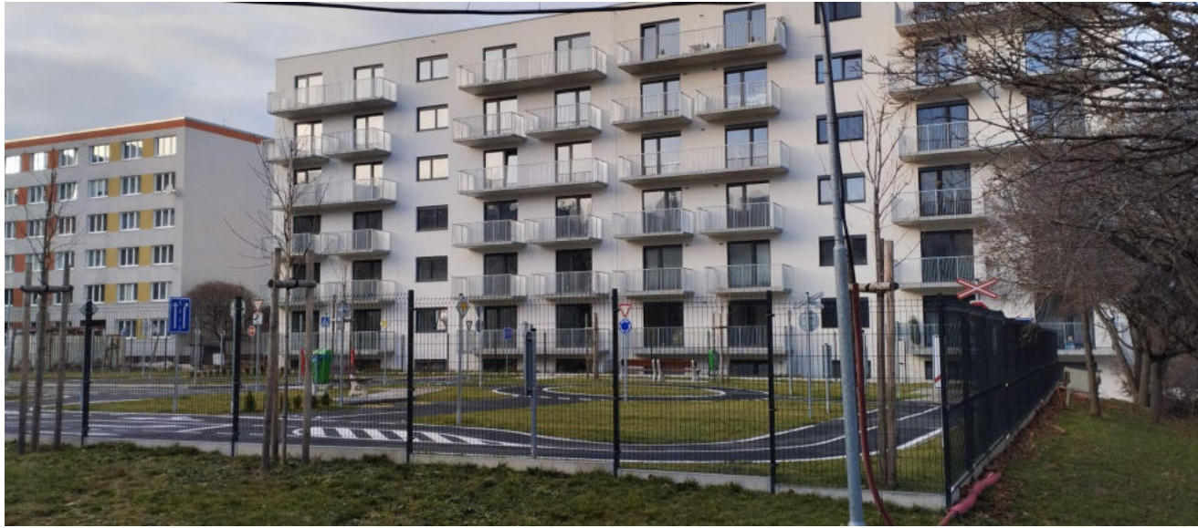
Obrázek číslo 43: Dopravní hřiště s vysokým oplocením, v pozadí nová bytová zástavba
