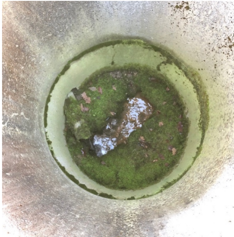
Obrázek 16 Pohled do meliorační šachty v řešeném území, zdroj: autor
