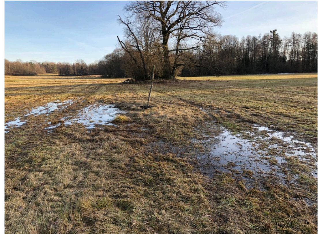
Obrázek 51 Podmáčená půda v okolí meliorační šachty, zdroj: autor
