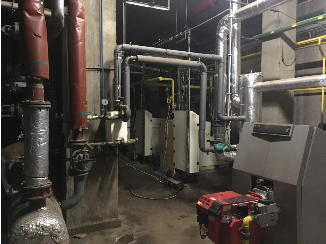
Obrázek 2: Kotelna: 2 kogenerační jednotky TEDOM MICRO 30 a plynový kotel (vpravo)
