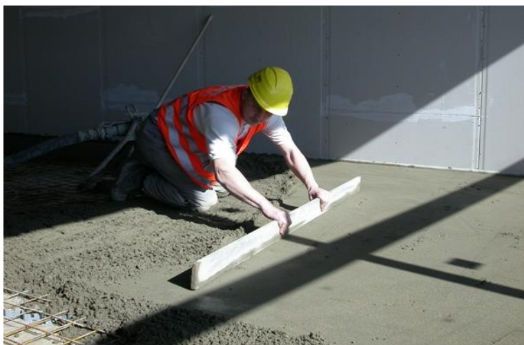
Obr. 8 – Pokládka cementového potěru ze zavhlé směsi, převzato z [49]
