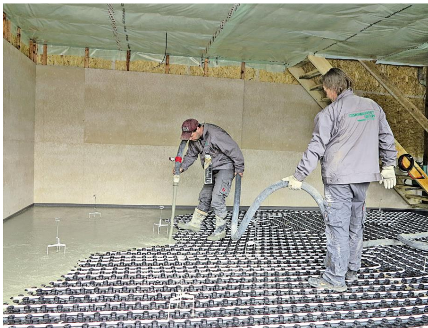
Obr. 9 – Ukládání cementového litého potěru, převzato z [52]
