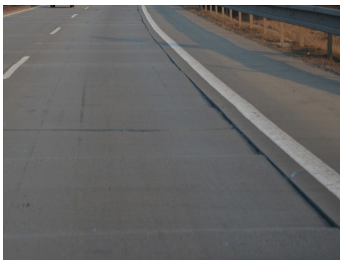
Obrázek 2 – schody na spárách, dálnice D1 (Rousínov), převzato z [9]
